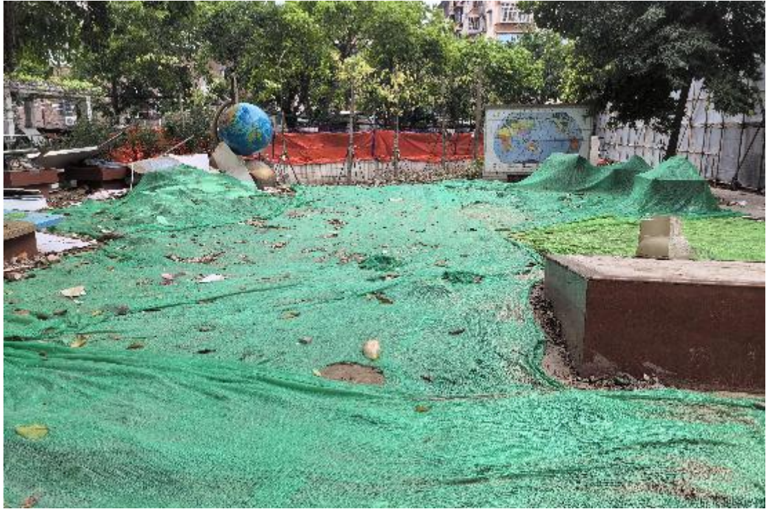
图 22 地块内现状（西-东）
