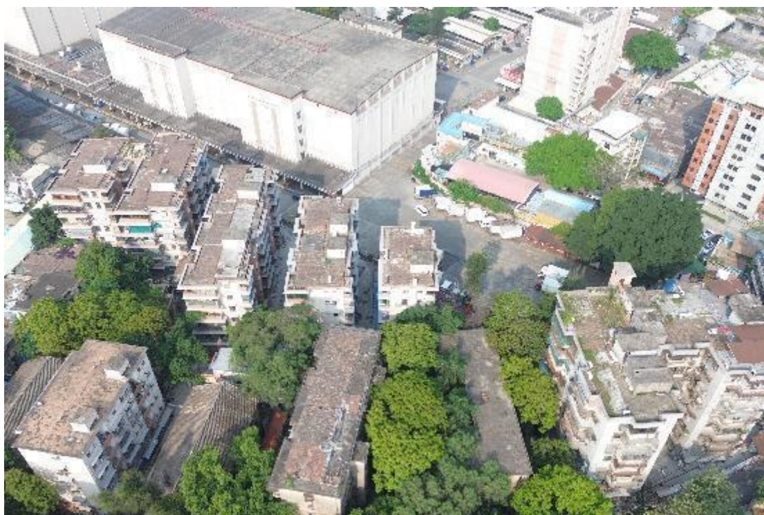
图 19 地块外西部地形地貌（东-西）
