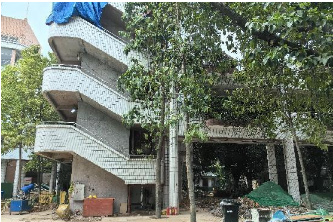
图 23 地块内现状（东-西）
