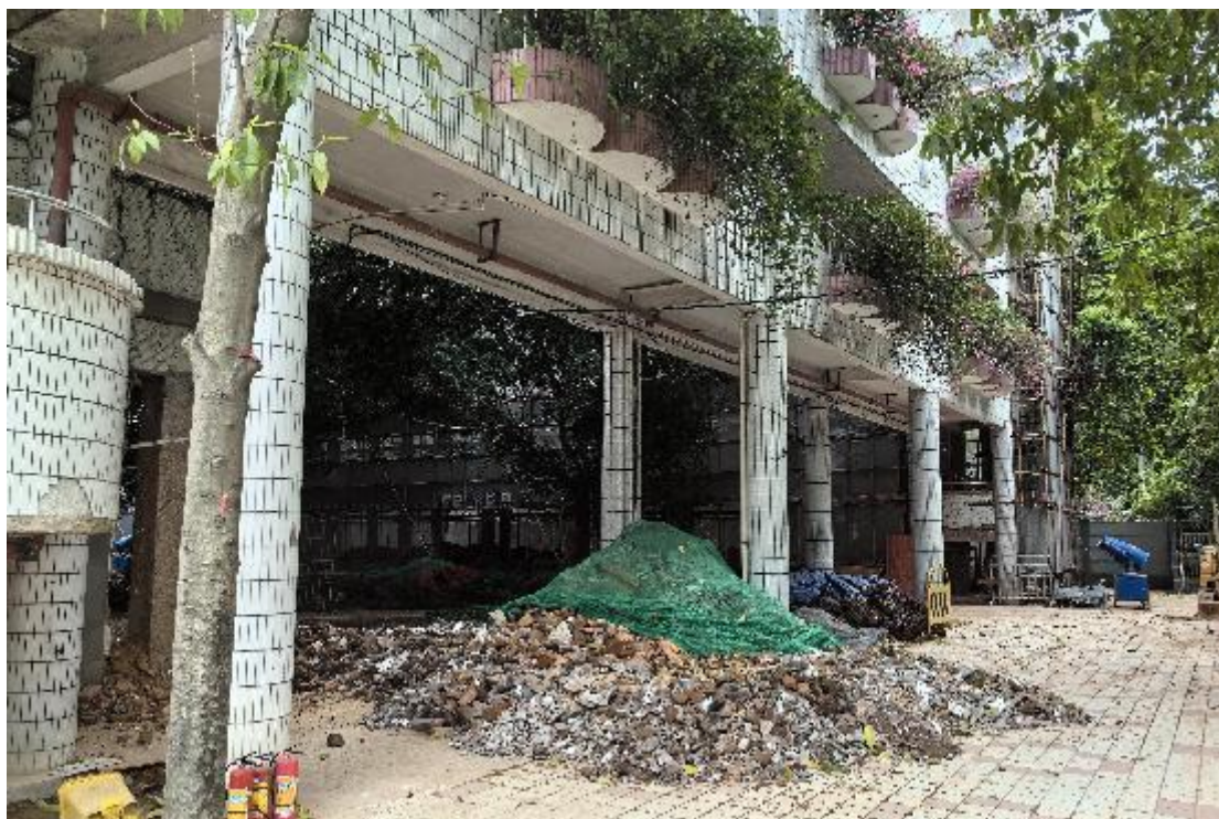
图 20 地块内现状（东南-西北）
