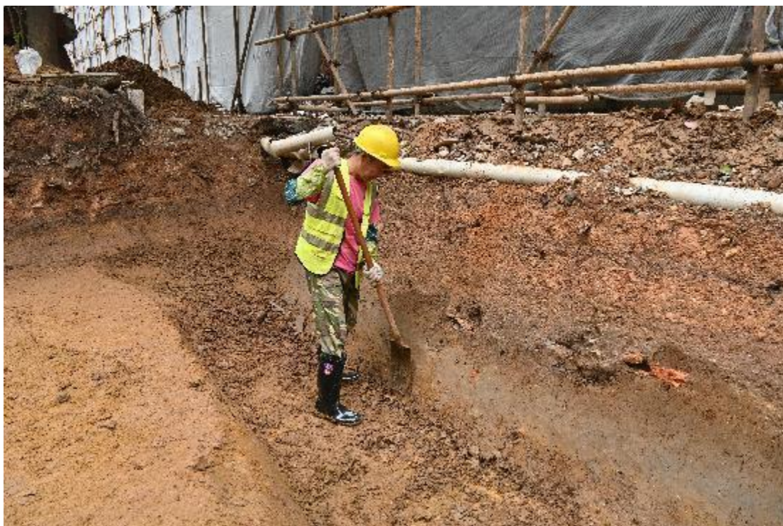
图 35 修整探沟壁（西北-东南）
