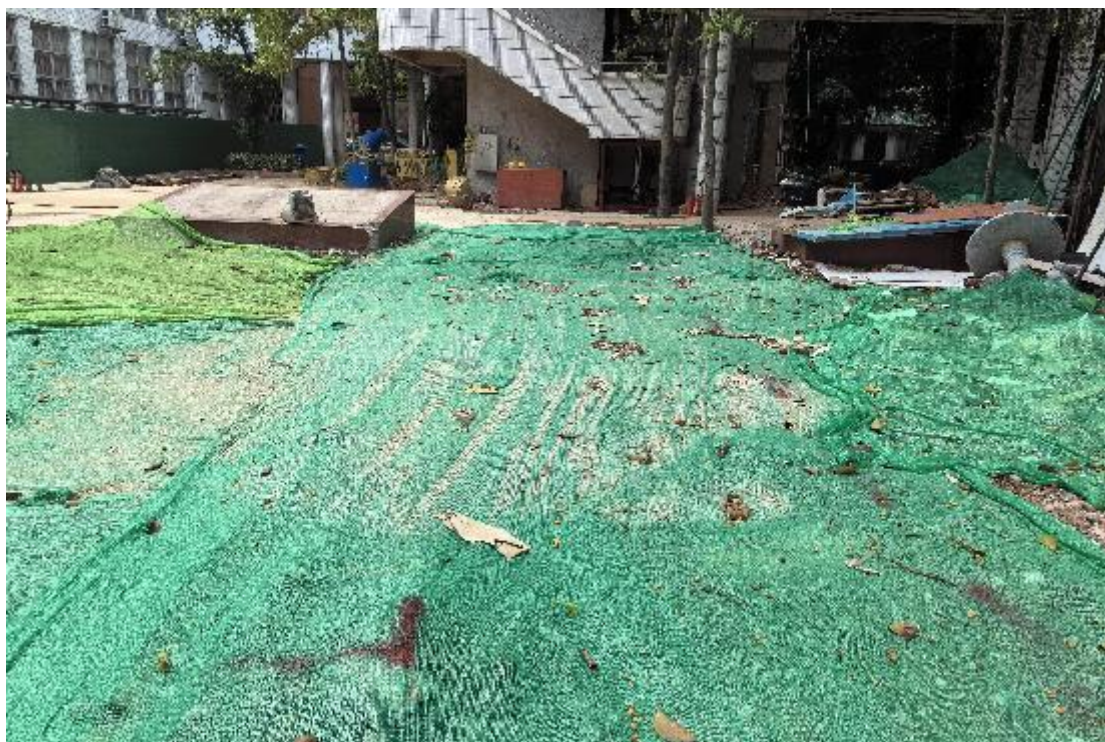
图 21 地块内现状（东-西）
