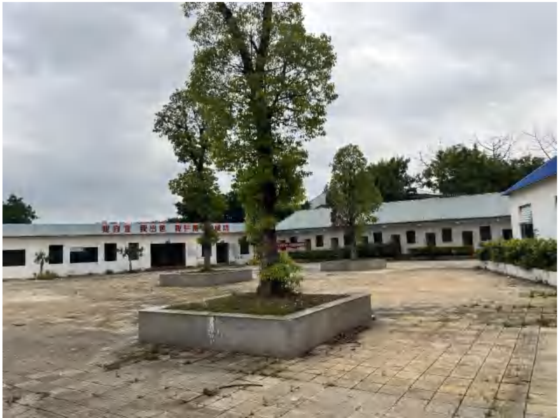
图 18 地块东部地表现状（北-南）
