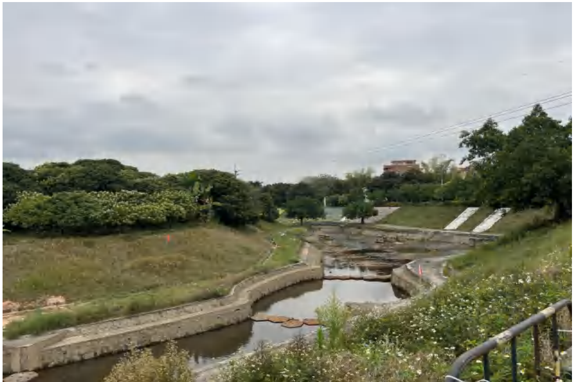
图 28 地块西部地表现状（北-南）
