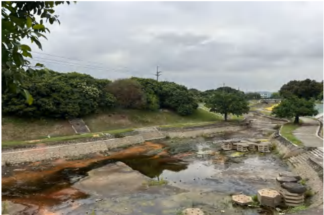
图 26 地块西部地表现状（西-东）
