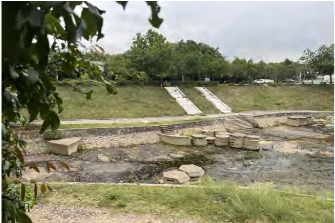
图 23 地块西部地表现状（北-南）
