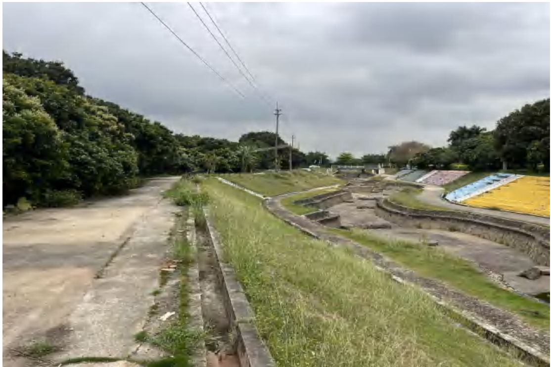
图 24 地块西部地表现状（西-东）
