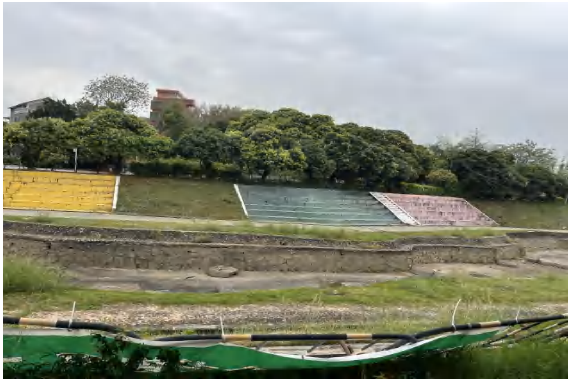
图 21 地块西部地表现状（北-南）
