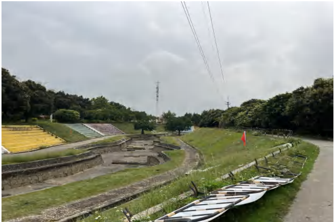
图 22 地块西部地表现状（东-西）
