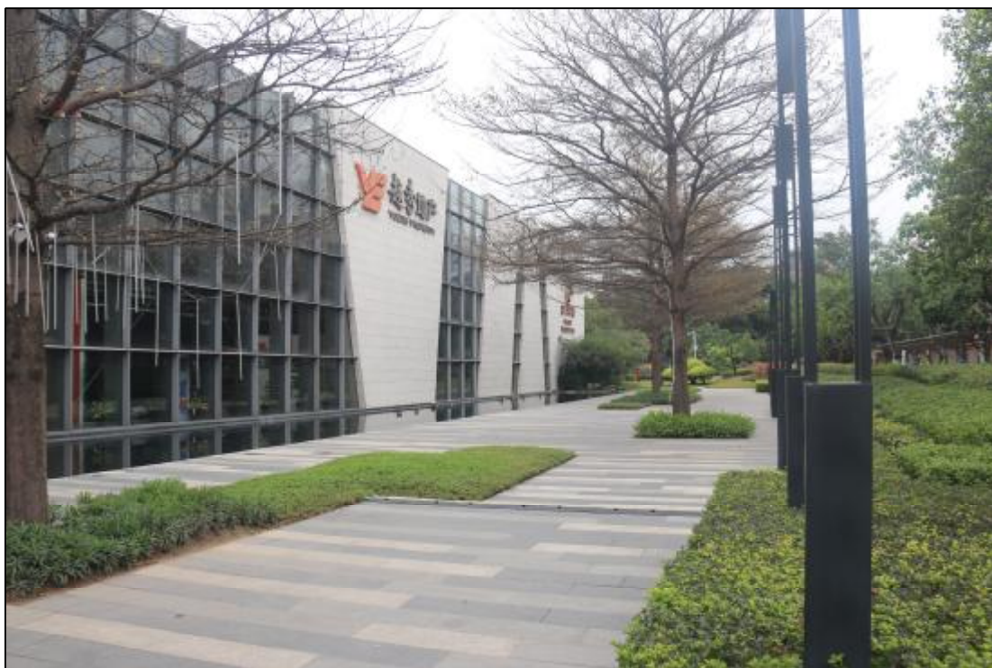
图 22 地块南部现状（西-东）
