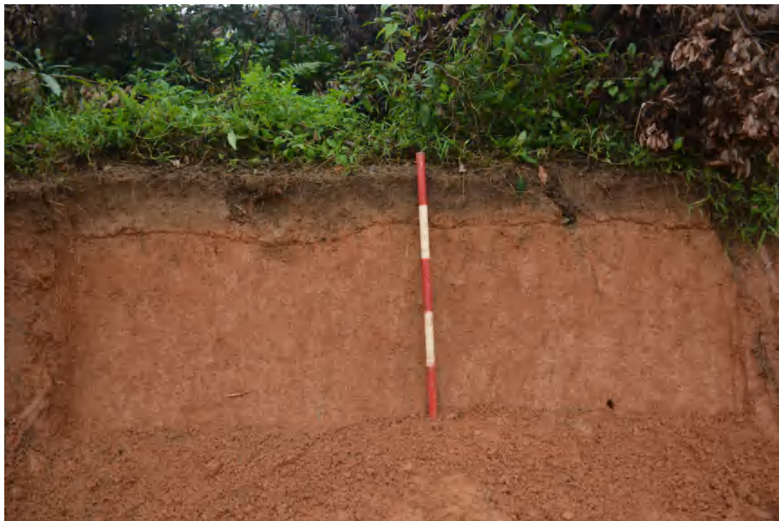
图 91 PM2 完工照（东-西）
