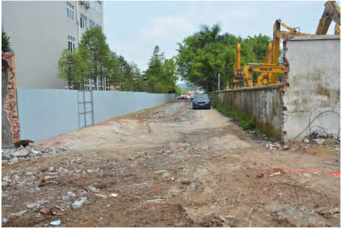
图 16 项目地块东区北部现状（南-北）
