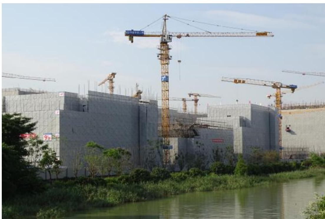
图 19 调查四区（第 12 号场平）现状（南-北）
