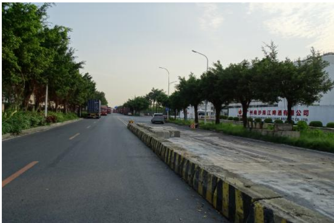
图 46 调查十九区地表现状（北-南）
