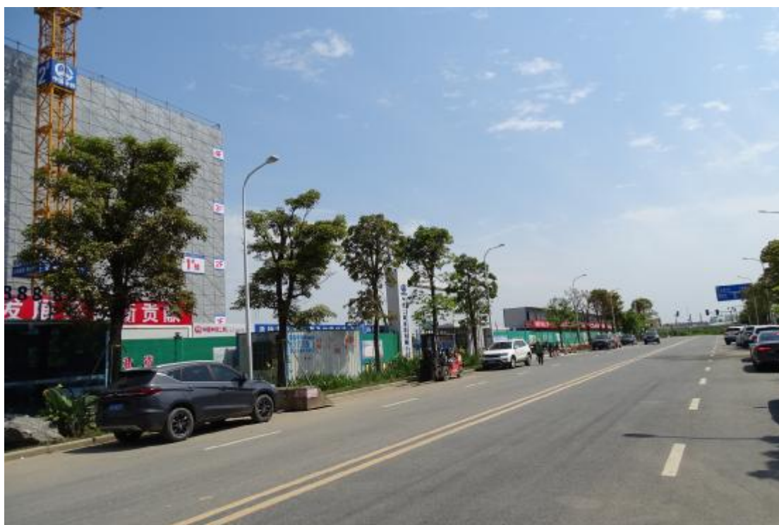
图 18 调查四区（第 12 号场平）现状（南-北）
