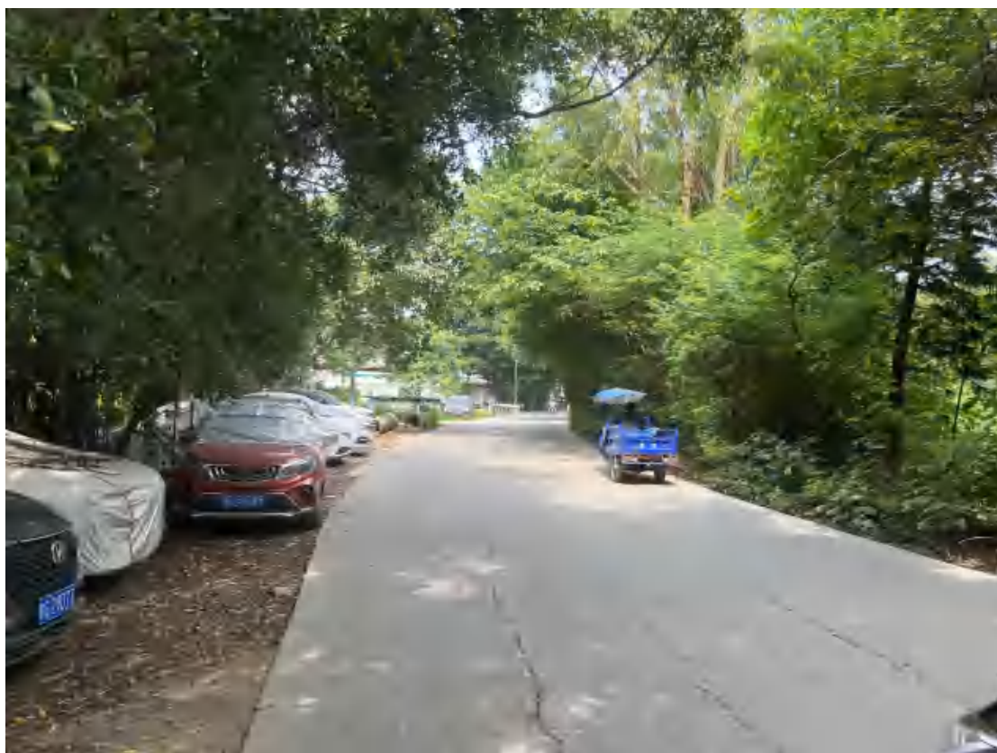
图 38 地块西部地表现状（西-东）
