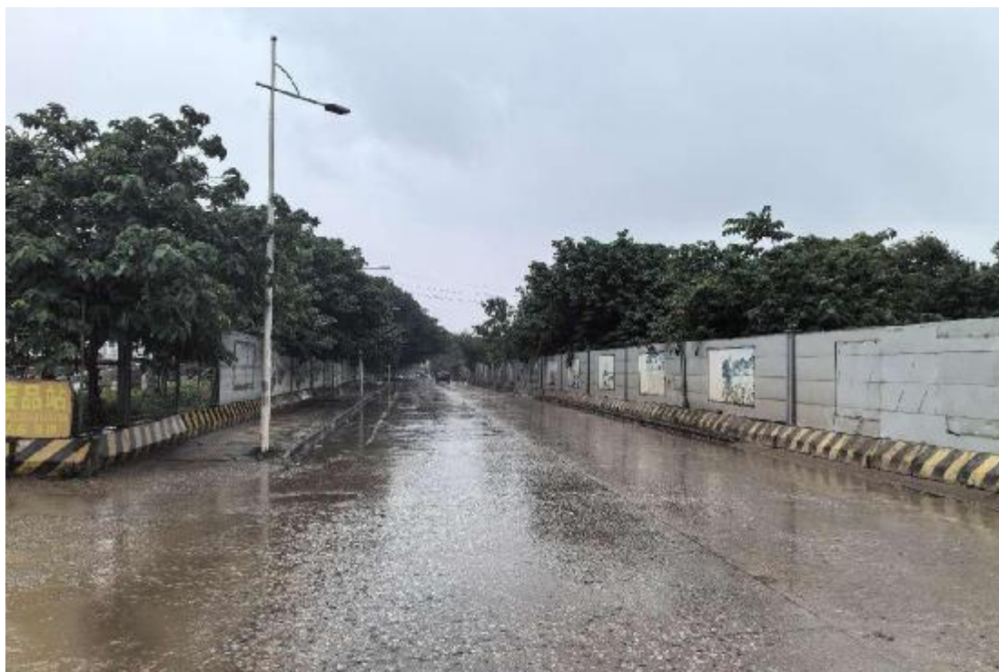
图 14 石化北路内现状（南-北）
