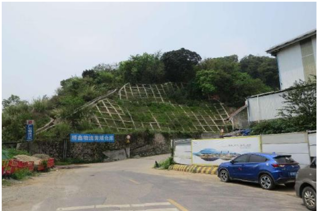
图 9 石化北路内现状（东-西）
