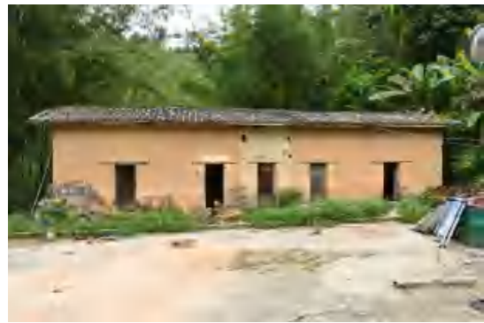
图 239 采集点房屋正面
