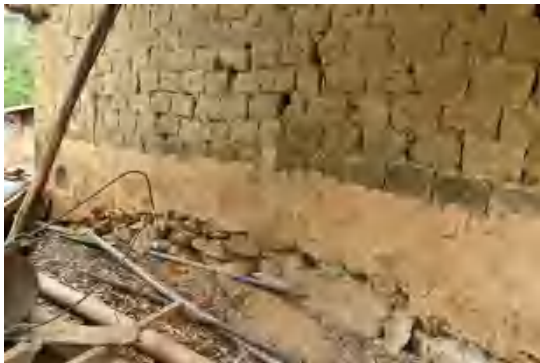
图 224 采集点 1 房屋侧面底部
