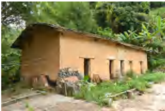
图 240 采集点房屋侧面
