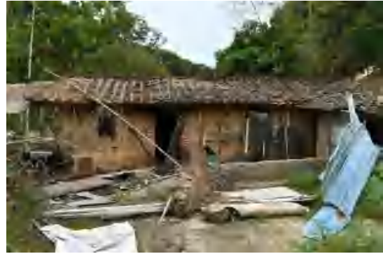
图 223 采集点 1 房屋侧面
