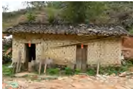
图 233 采集点房屋正面
