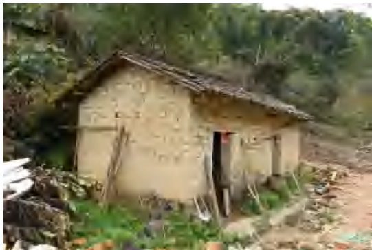
图 234 采集点房屋侧面
