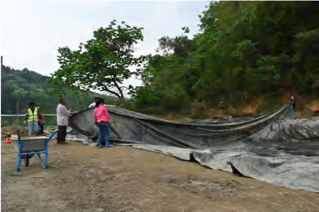
图 89 遮盖防水布工作照（东南-西北）
