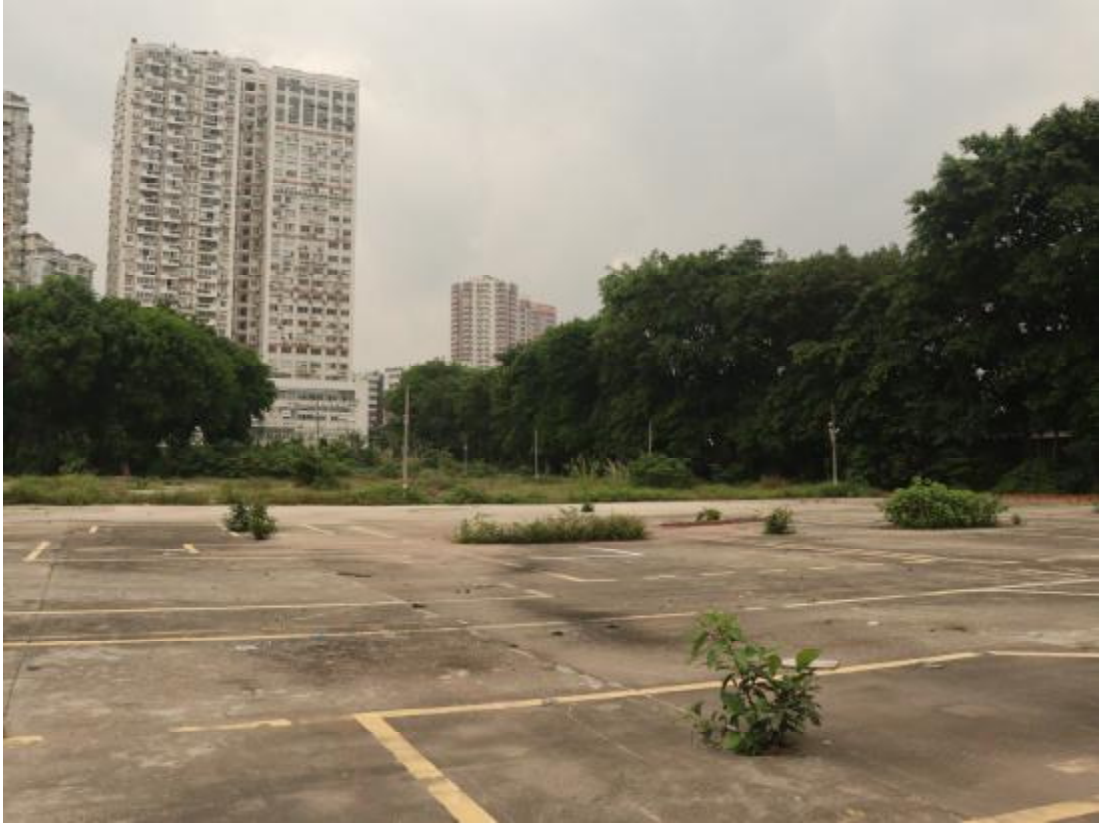
图 20 地块东南部现状（西北-东南）
