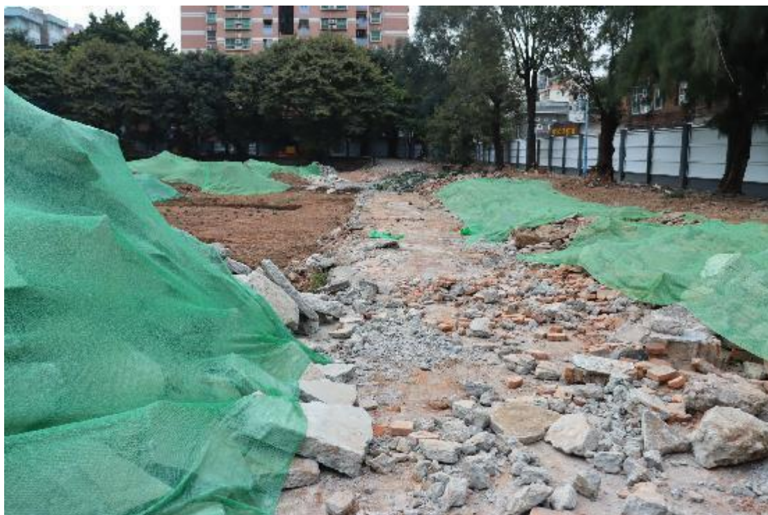
图 23 勘探区域现状（北-南）
