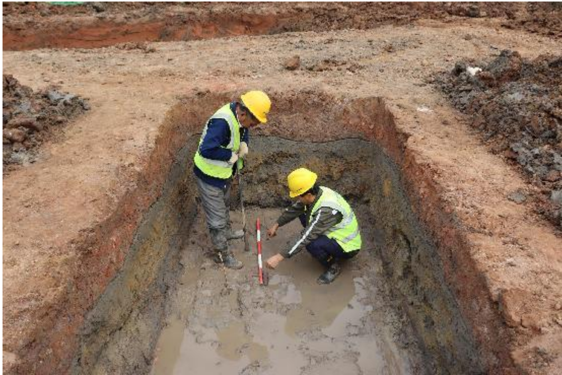
图 68 提取探沟底部土样（南-北）
