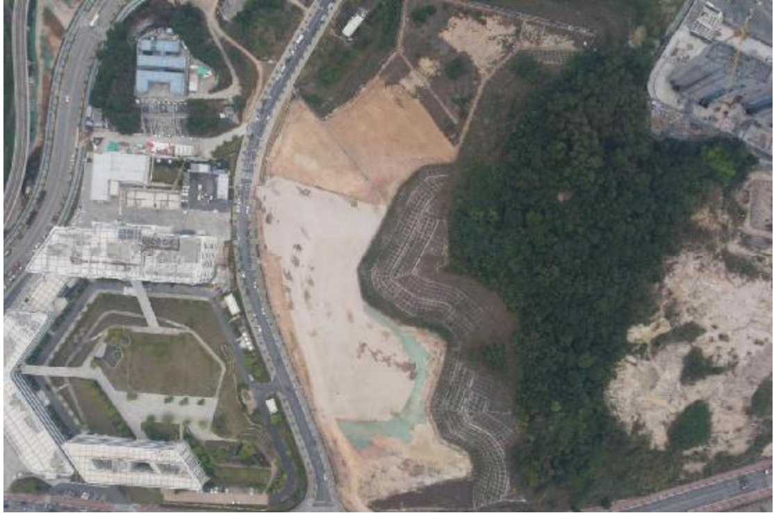
图 9 地块南部区域全景航拍（俯视）
