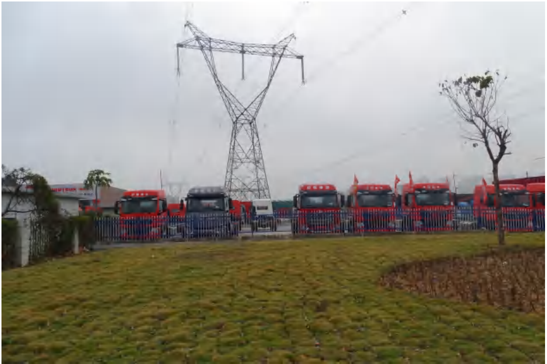
图 16 地块西部地表现状（西-东）
