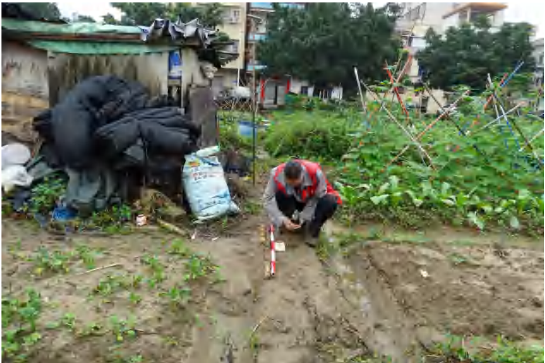
图 37 试探孔坐标测量（南-北）
