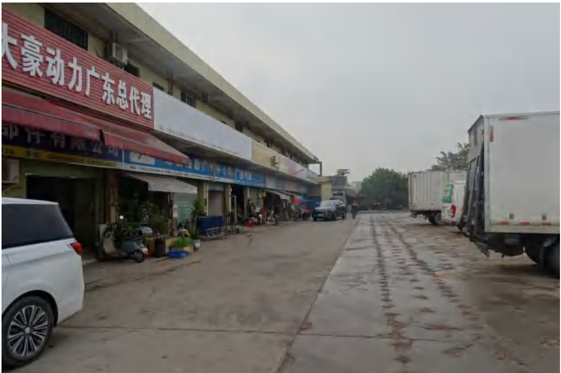
图 13 地块西部地表现状（北-南）
