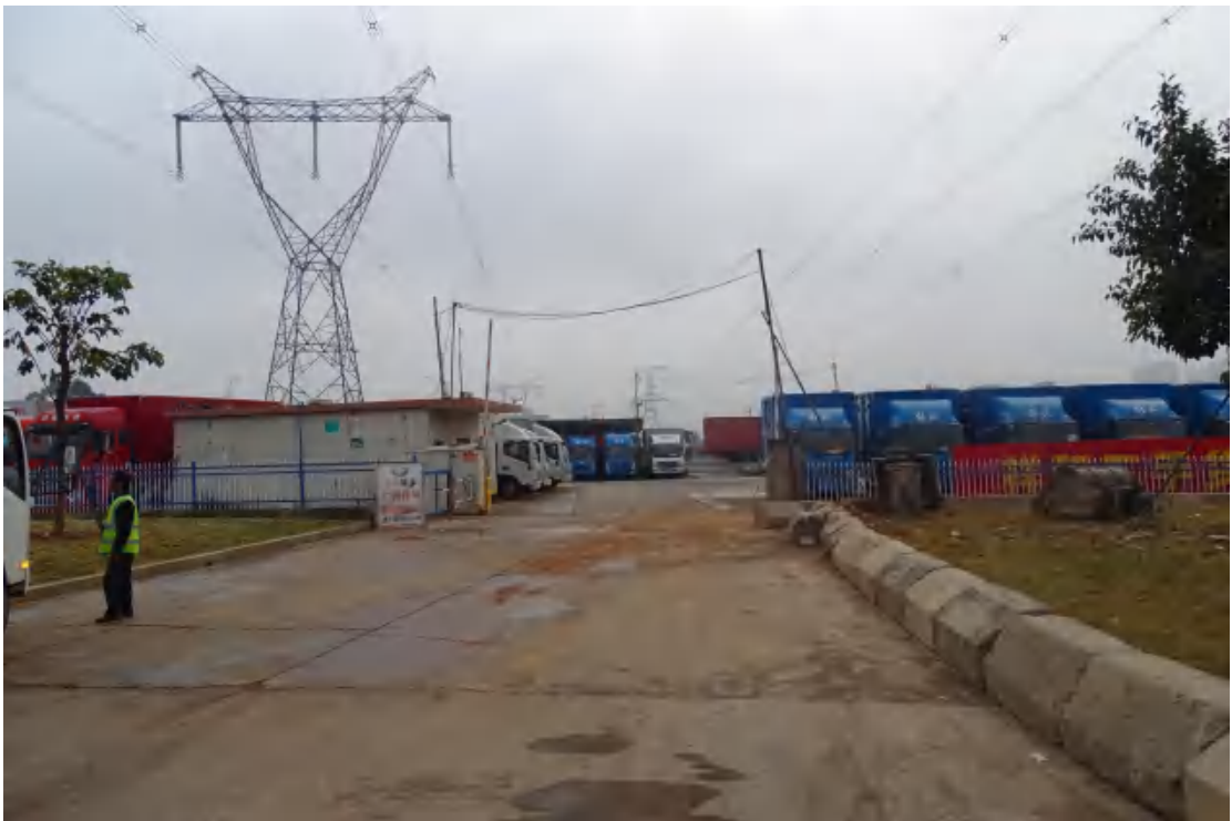
图 15 地块西部地表现状（西-东）
