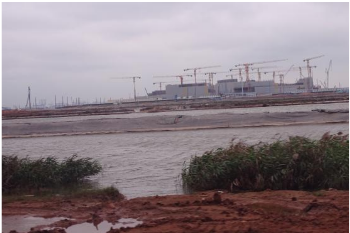
图 19 工程用地地表现状（西-东）
