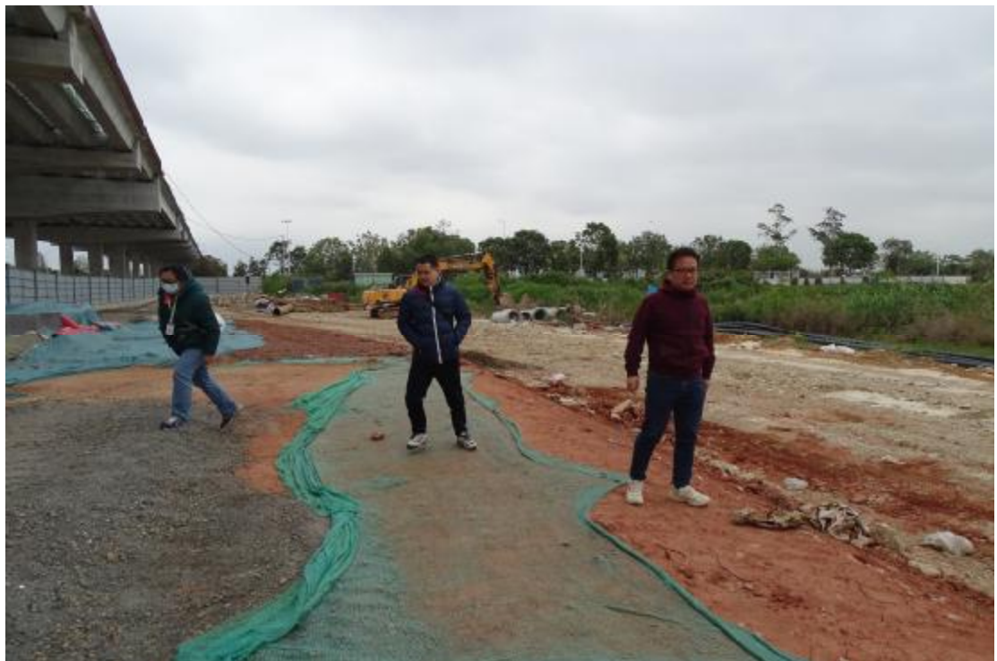
图 7 对工程用地地表进行踏查（南-北）
