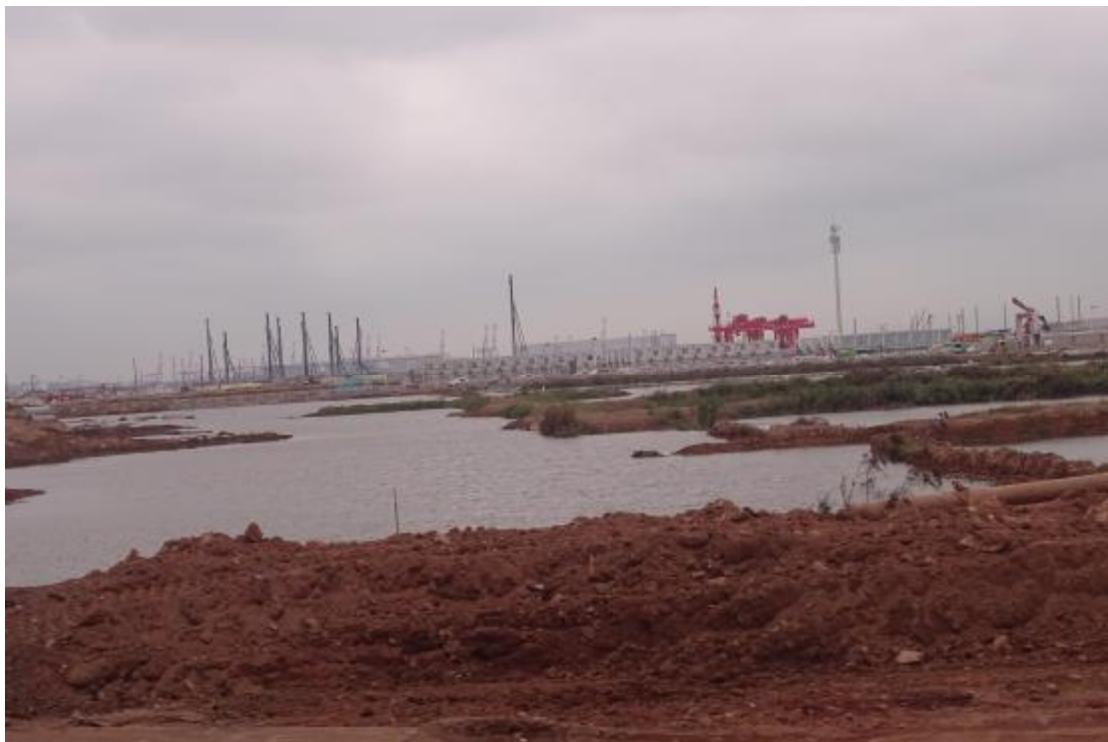
图 21 工程用地地表现状（西-东）
