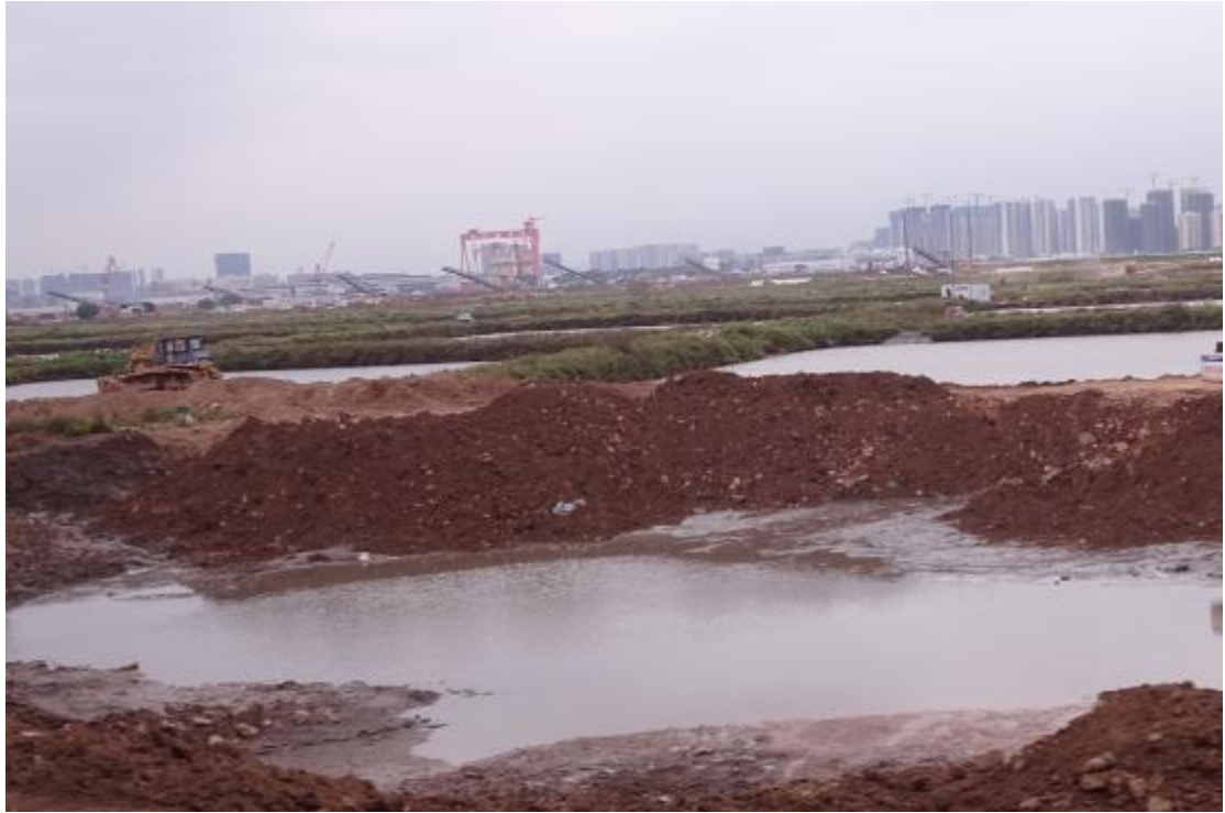
图 18 工程用地地表现状（东-西）
