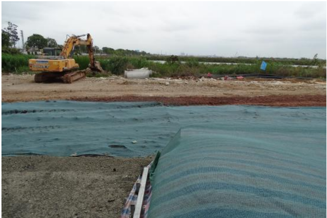
图 9 工程用地地表现状（西-东）
