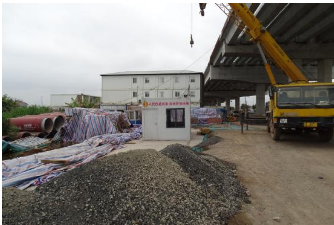
图 13 工程用地地表现状（南-北）
