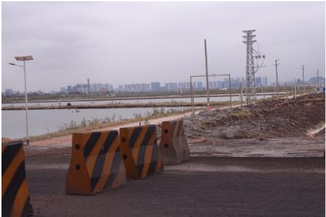
图 15 工程用地地表现状（东-西）
