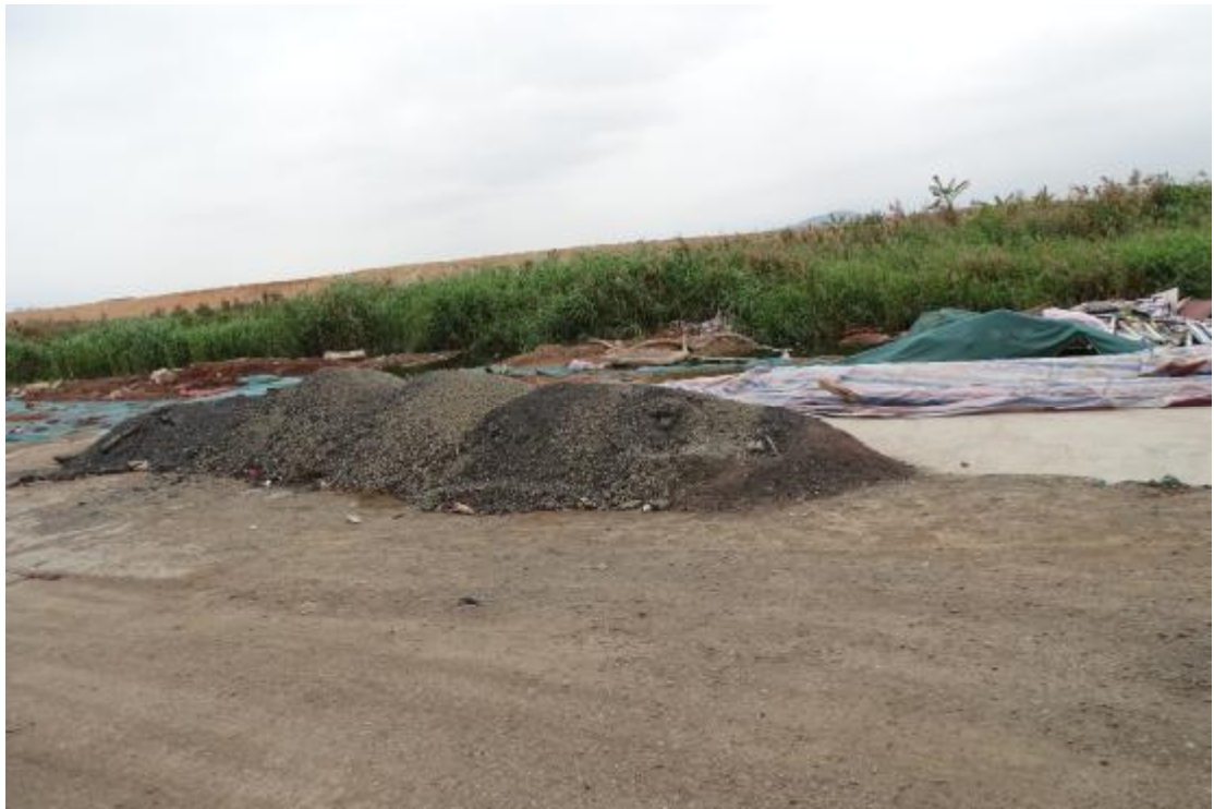
图 11 工程用地地表现状（东-西）
