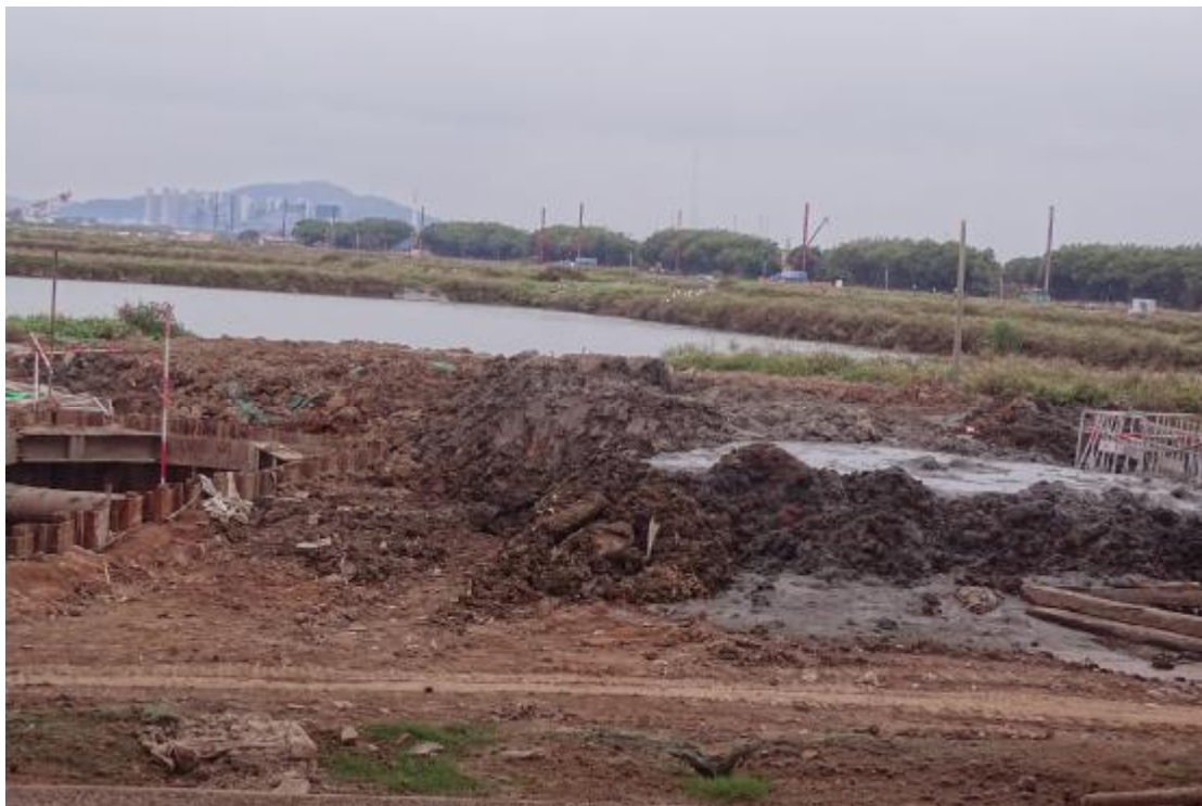
图 20 工程用地地表现状（西-东）
