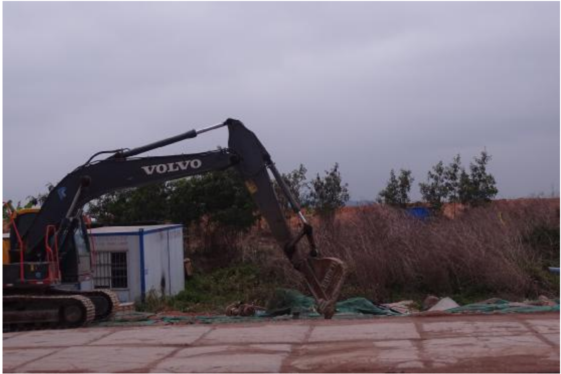
图 14 工程用地地表现状（东-西）
