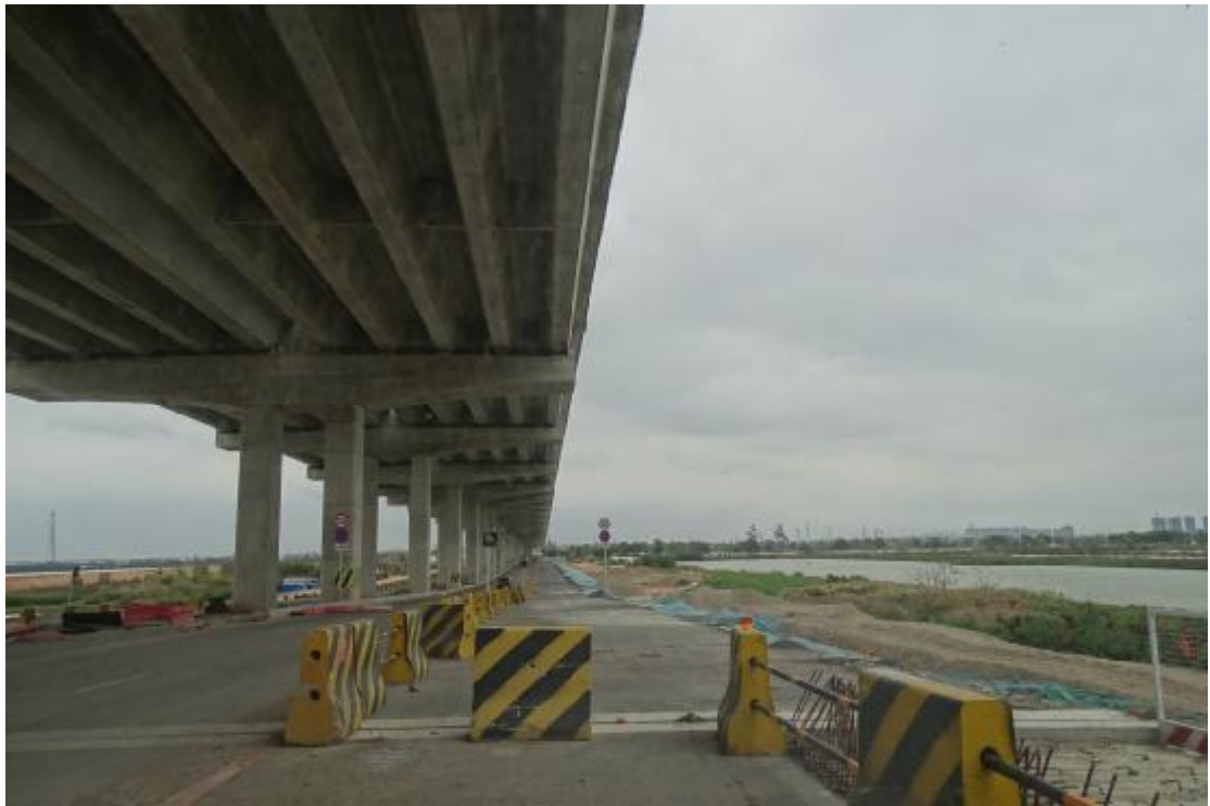
图 23 工程用地地表现状（南-北）
