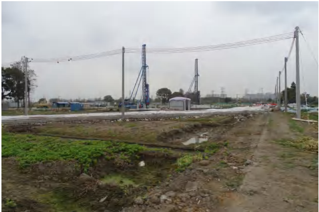
图 35 地块西部地表现状（北-南）
