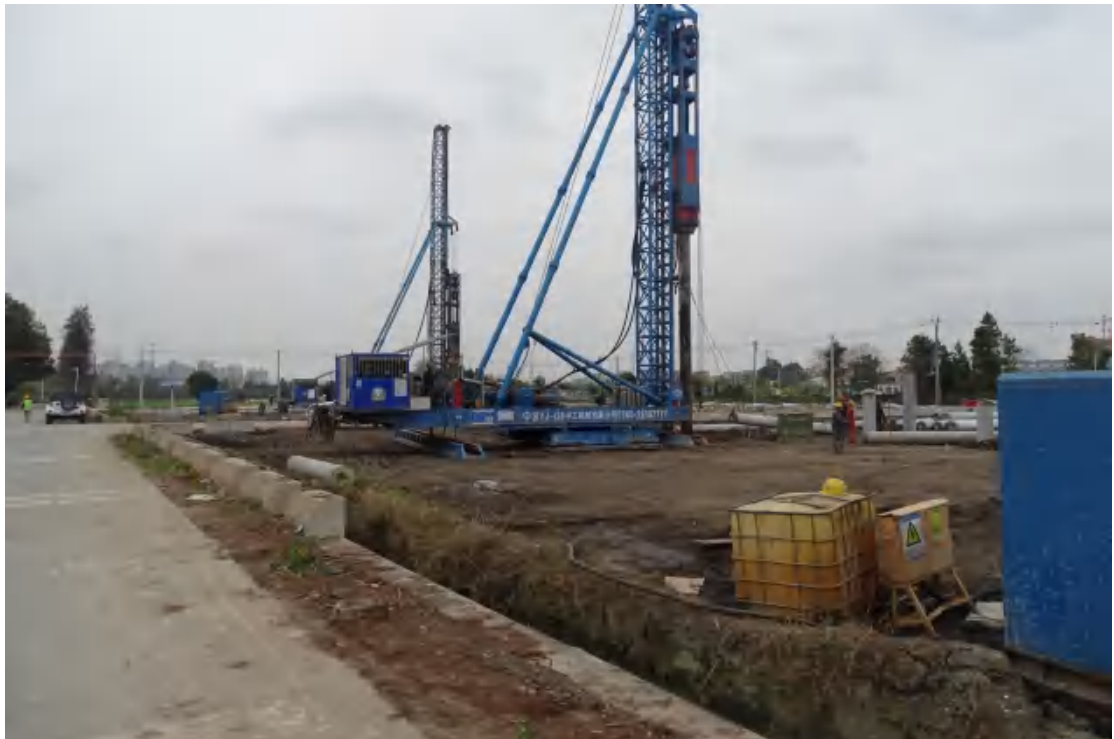
图 39 地块西部地表现状（东北-西南）
