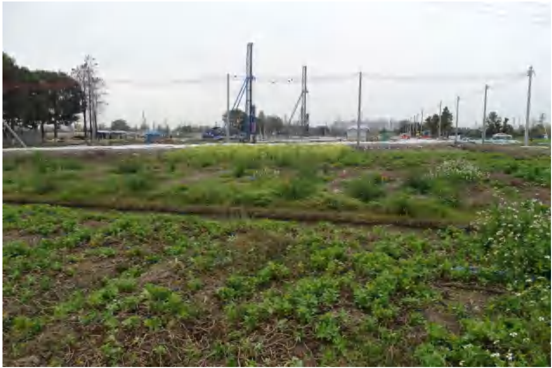
图 34 地块西部地表现状（北-南）
