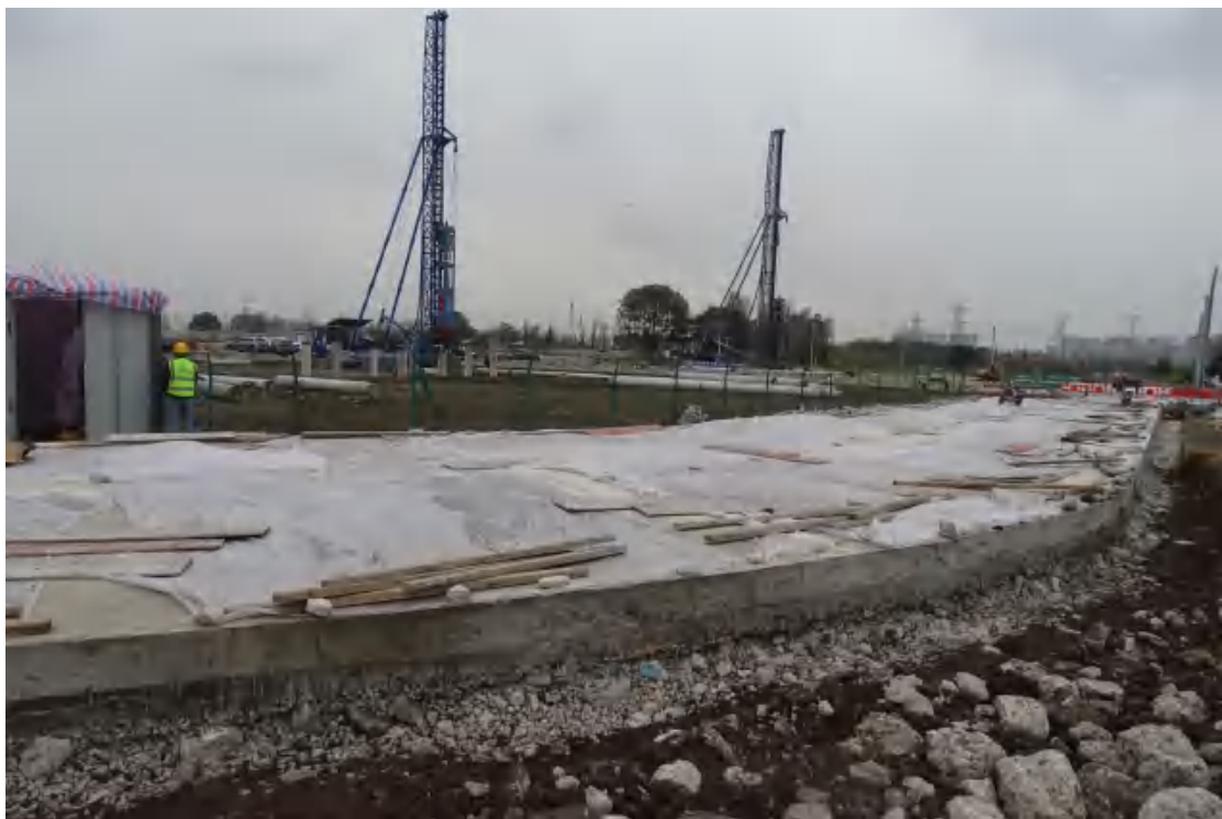
图 37 地块西部地表现状（北-南）
