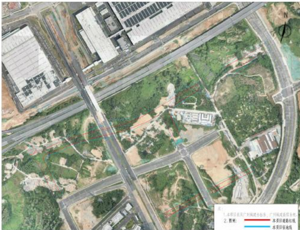
图 5 工程用地航拍图（建设方提供）
