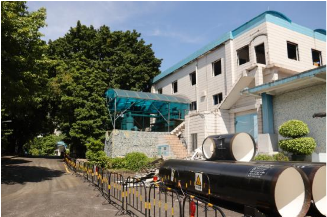
图 20 项目地块内部地貌（东-西）
