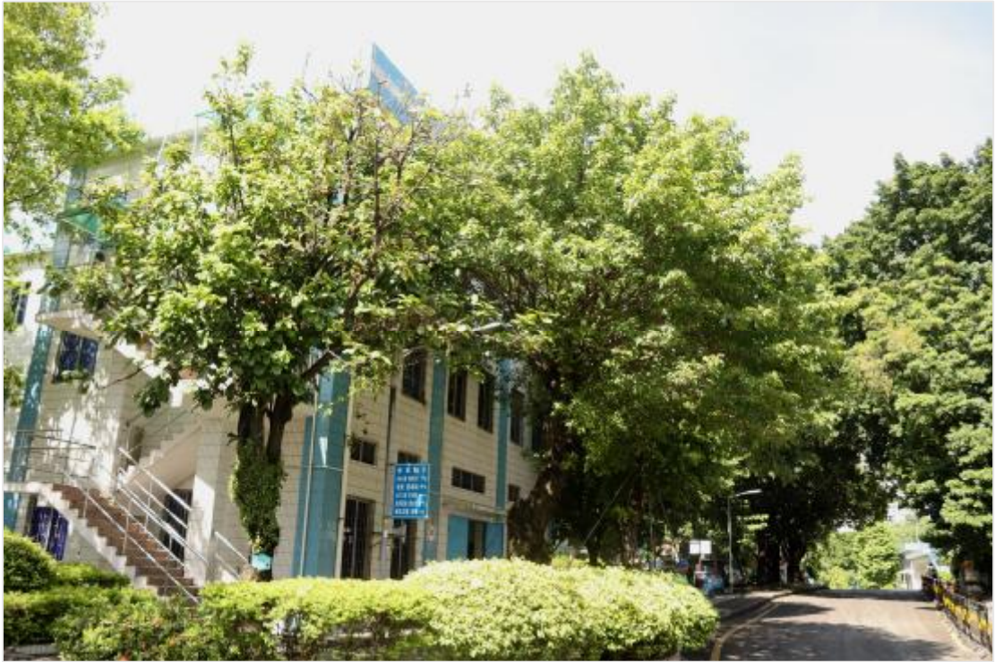
图 19 项目地块内部地貌（东-西）
