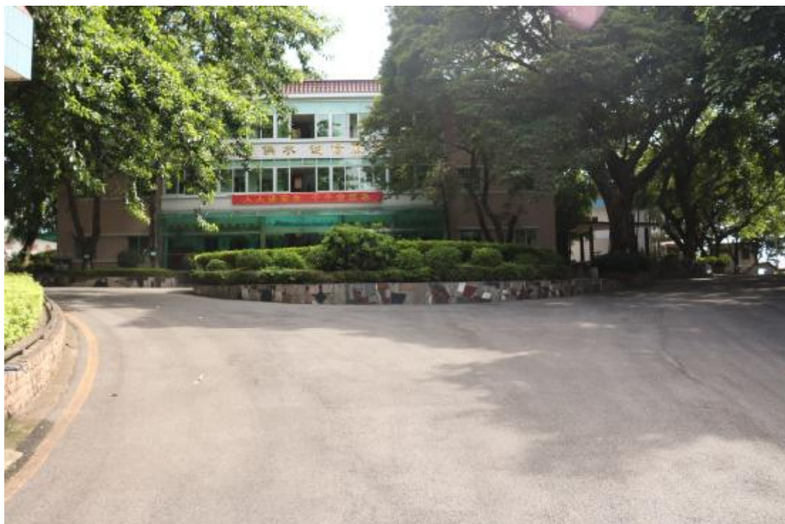
图 18 项目地块内部地貌（东-西）
