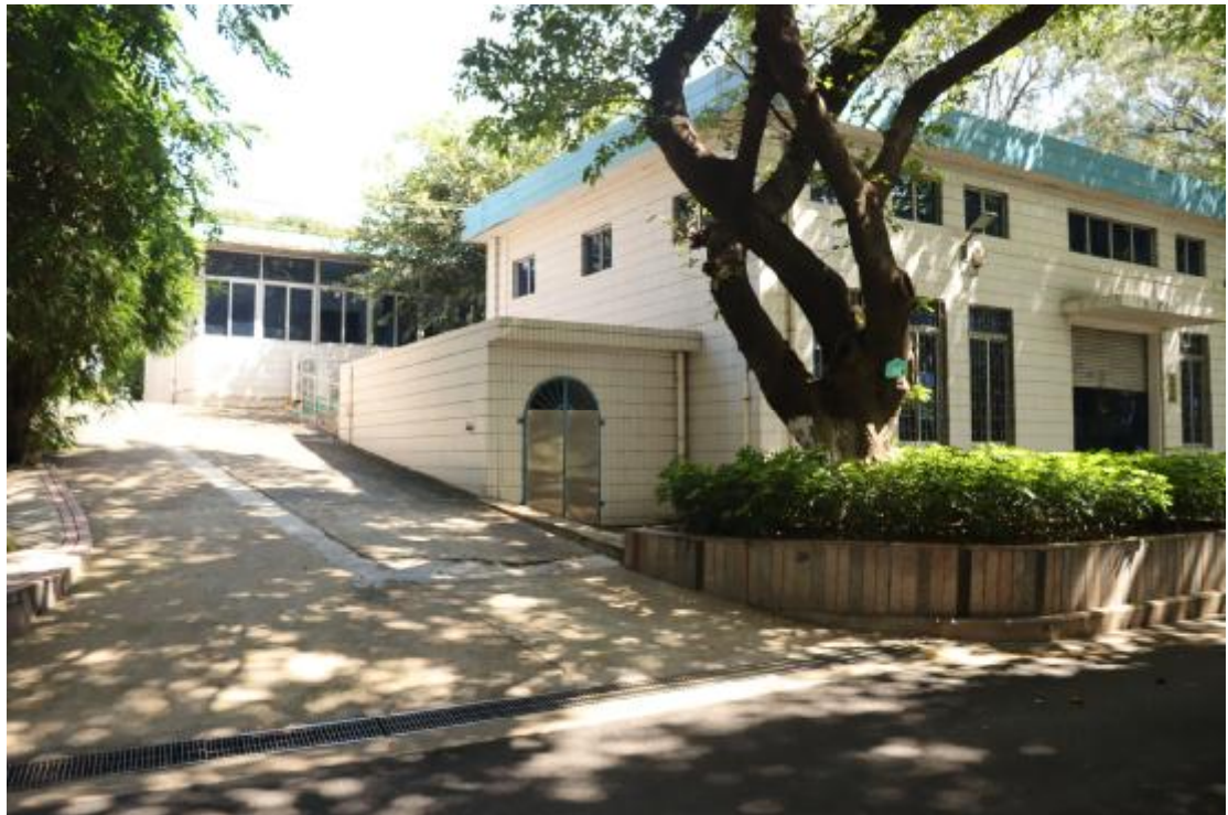
图 22 项目地块内部地貌（西-东）
