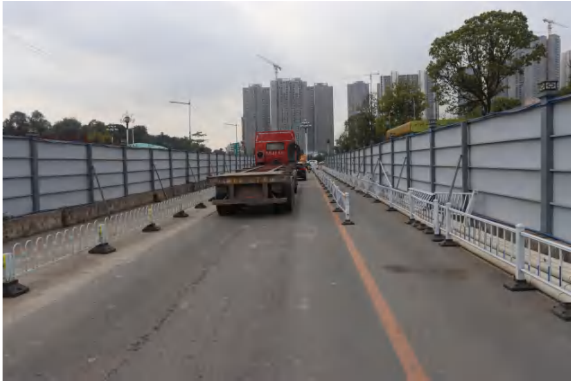
图 24 地块内现状（西北-东南）
