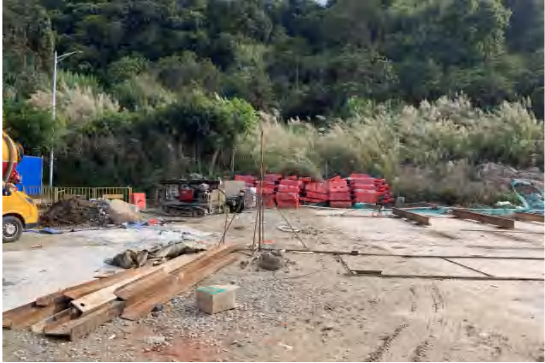
图 13 地块内现状（北-南）
