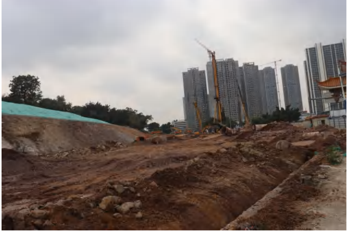
图 25 地块内现状（西北-东南）
