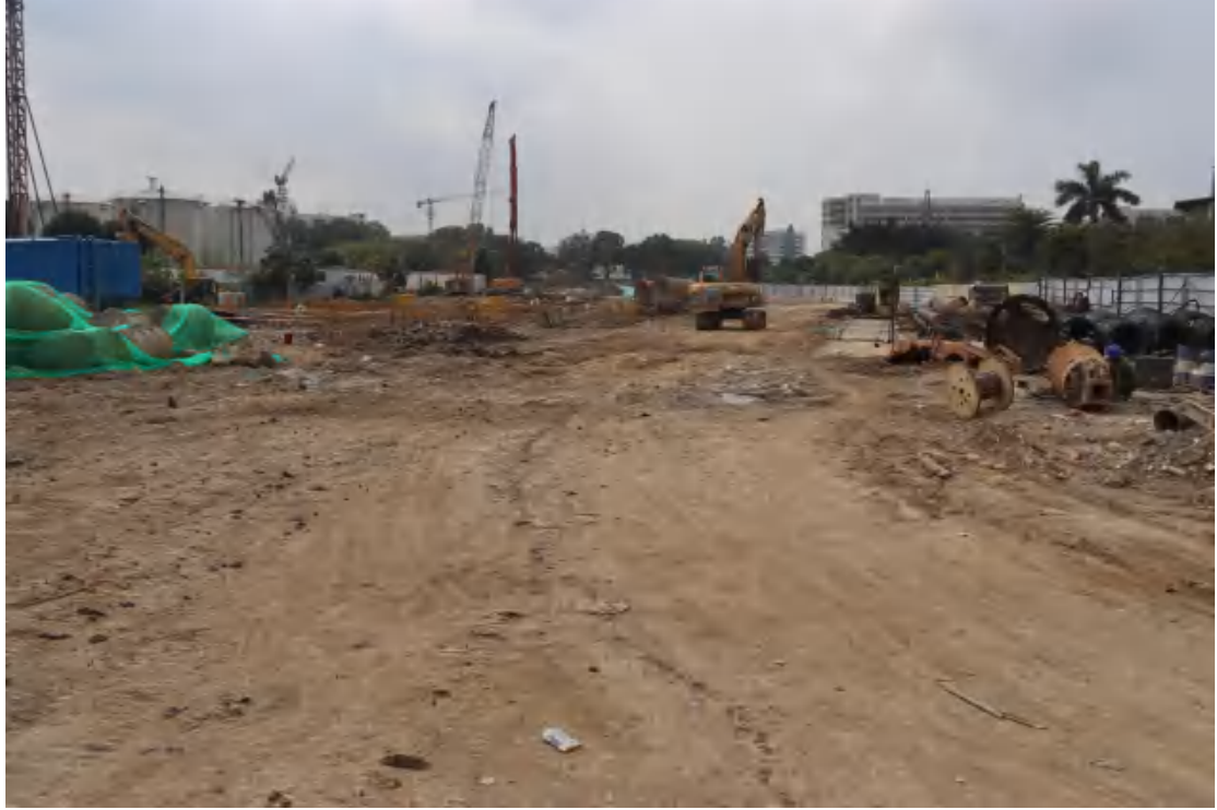
图 11 地块内现状（北-南）
