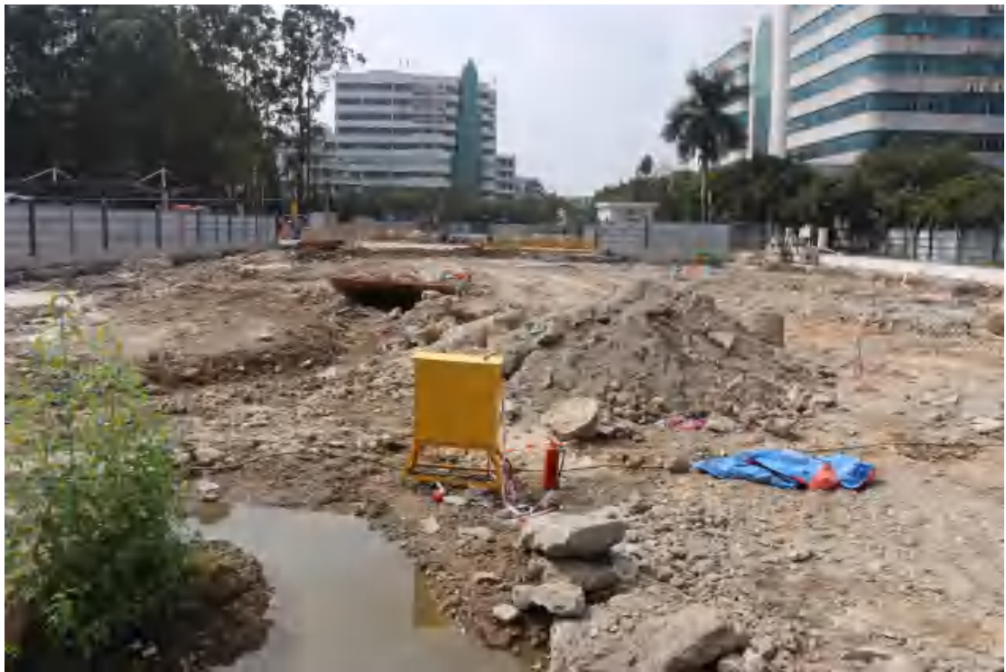
图 12 地块内现状（北-南）
