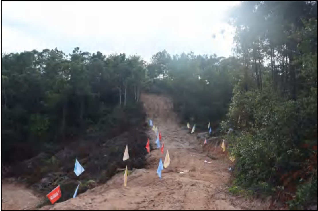
图 22 项目地块现状（南-北）
