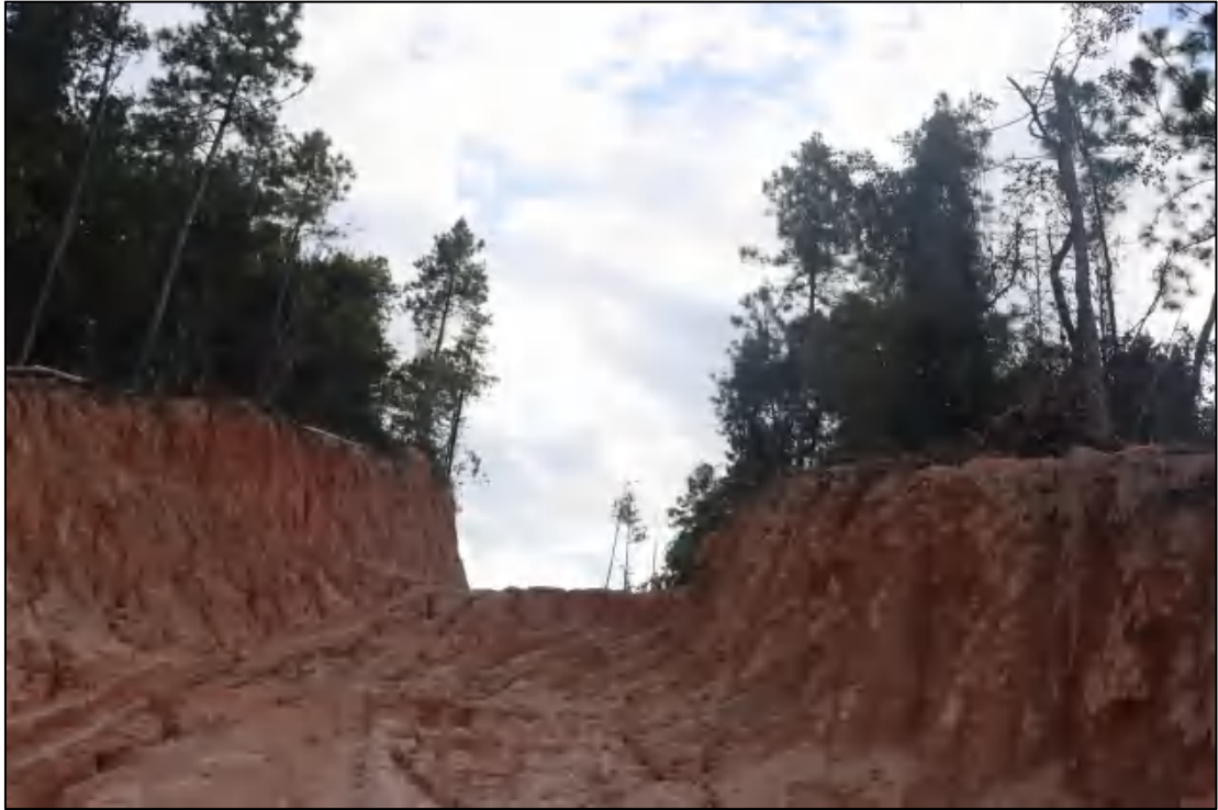
图 14 项目地块现状（东南-西北）
