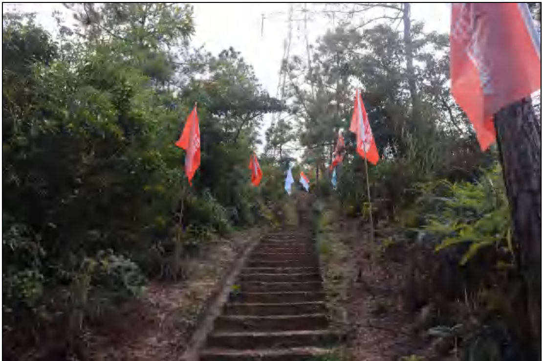
图 25 项目地块现状（西-东）
