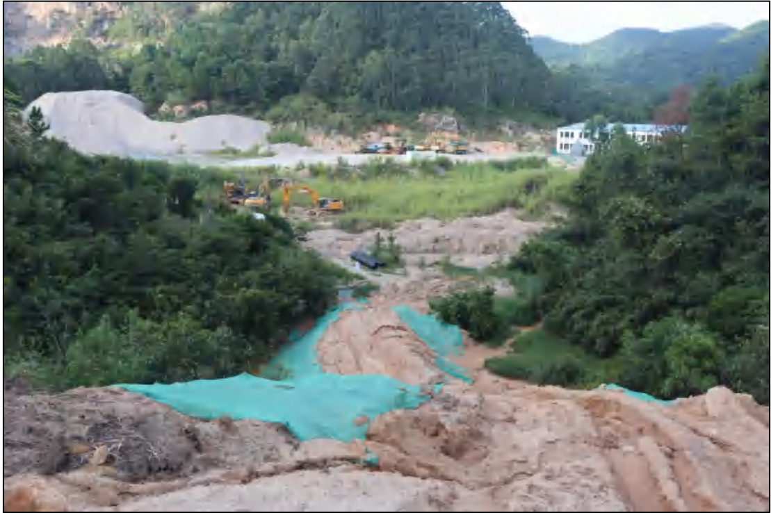
图 24 项目地块现状（西北-东南）
