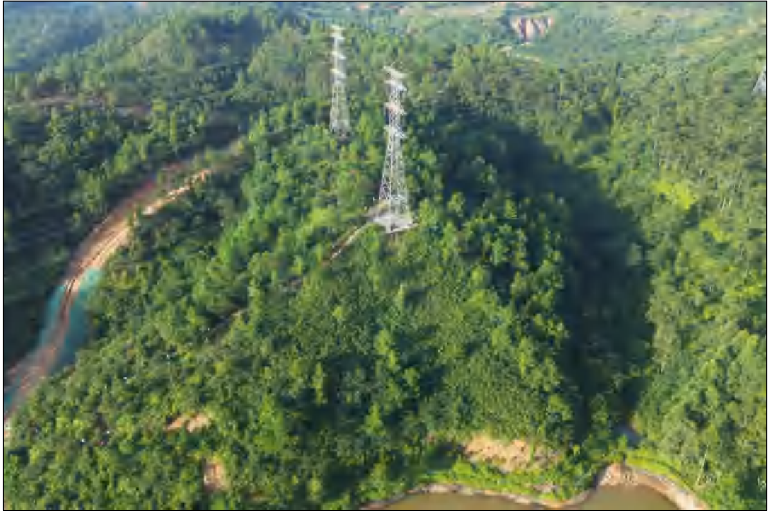
图 8 项目地块航拍照（南-北）
