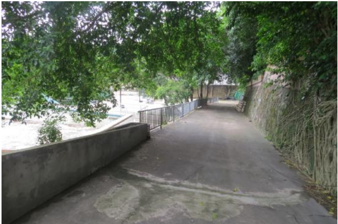
图 24 地块西部现状（北-南）
