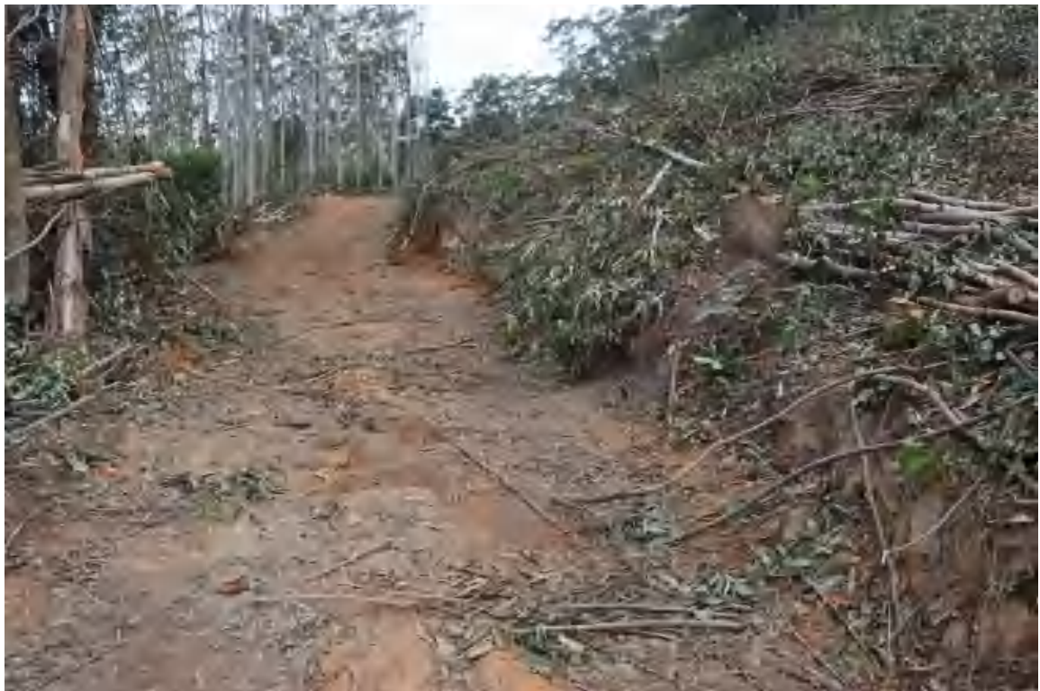
图 57 勘探区域现状（西-东）
