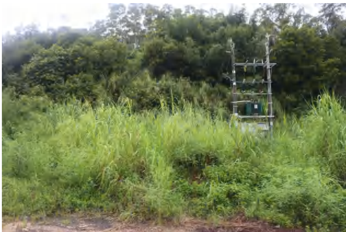
图 48 南地块西南部现状（西北-东南）
