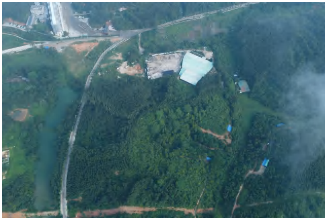
图 39 南地块全景（上西北下东南）
