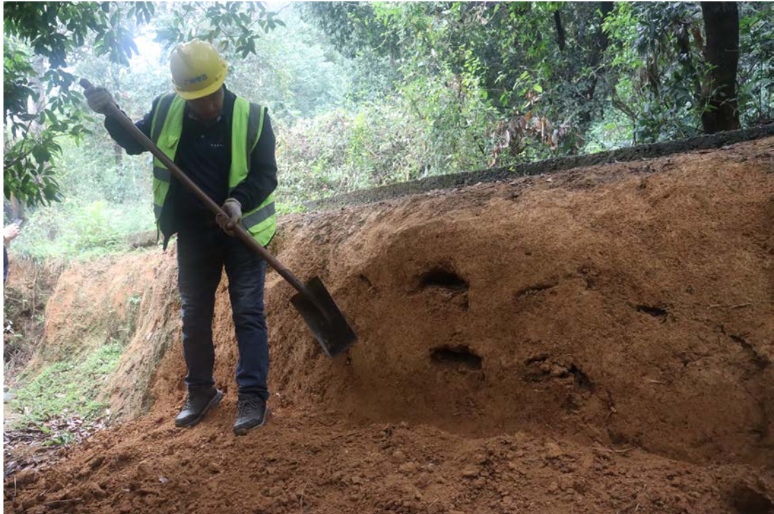
图 59 修整剖面（东北-西南）
