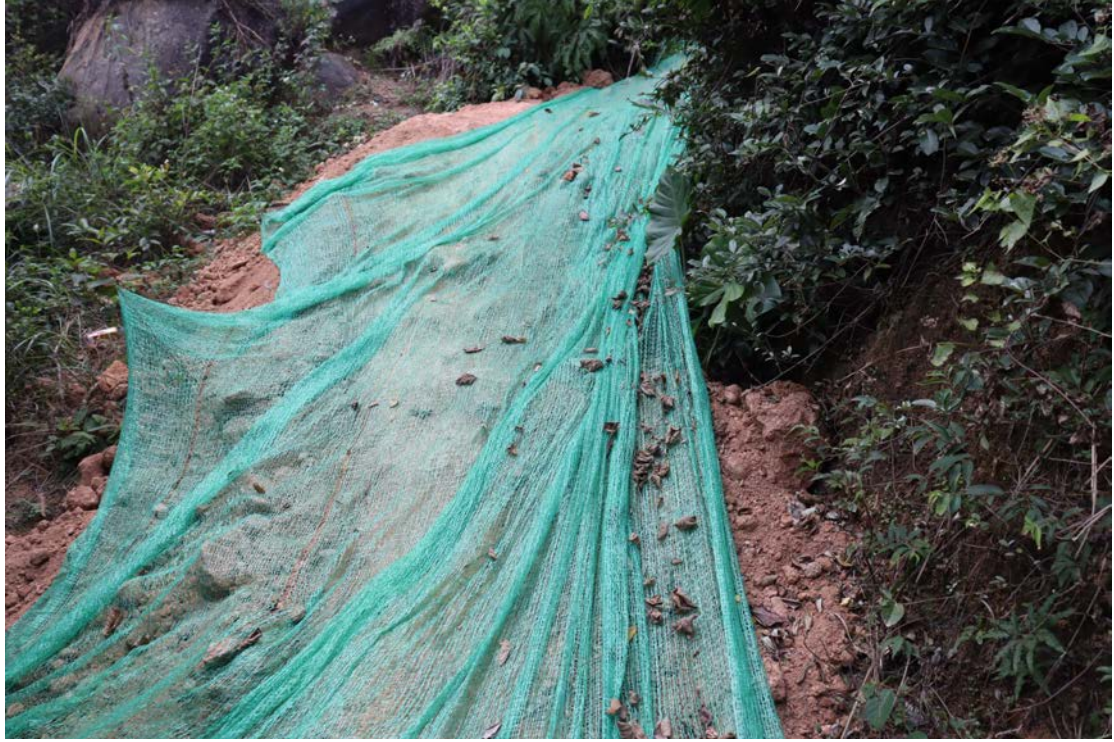
图 23 地块内现状（西北-东南）
