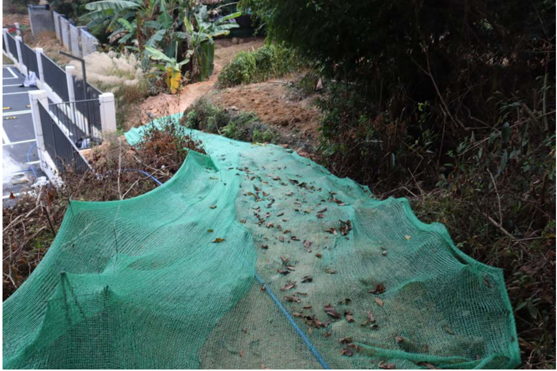
图 15 地块内现状（北-南）
