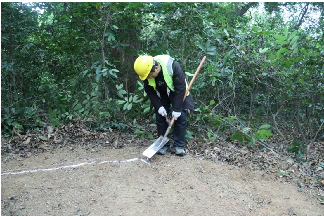
图 67 布设探沟（西北-东南）
