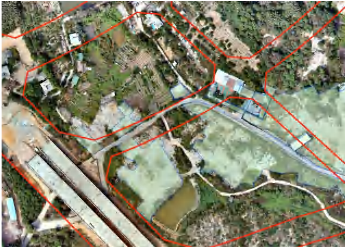
图 9 项目地块航拍全景（上北下南）
