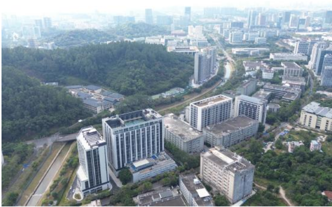
图 10 地块外南部现状（北-南）
