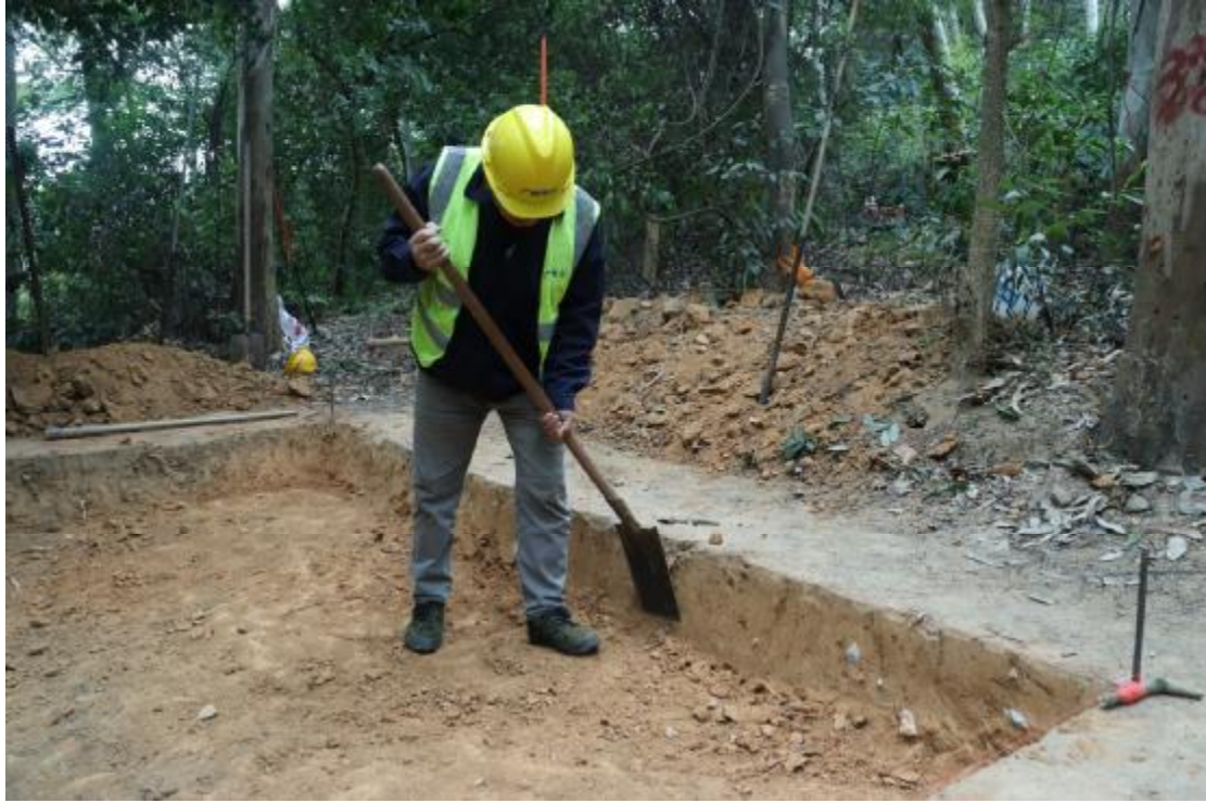
图 52 修整沟壁（东北-西南）
