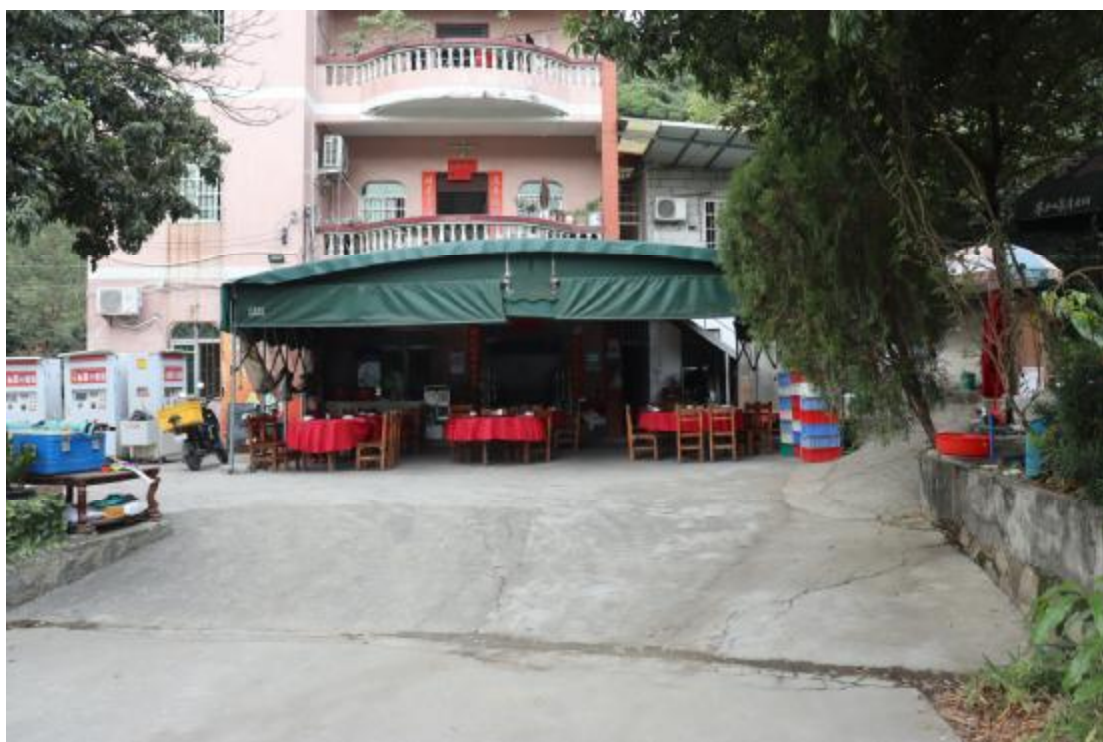
图 15 地块内现状（东-西）
