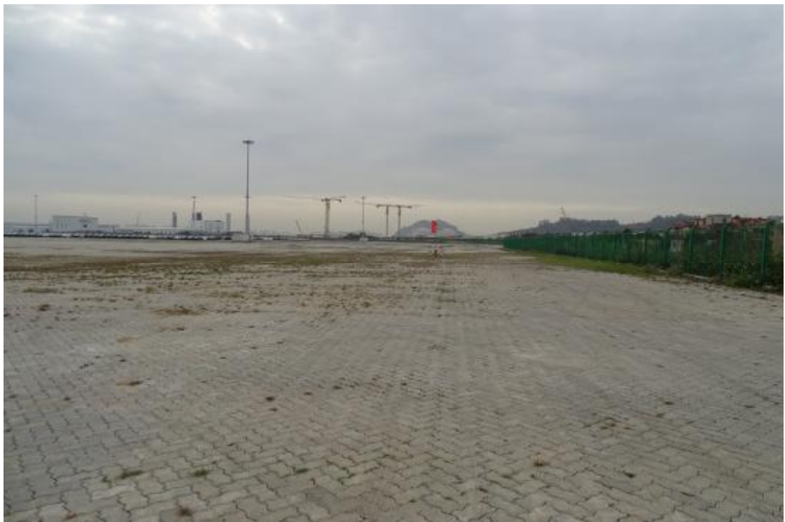
图 18 项目用地地表现状（北-南）
