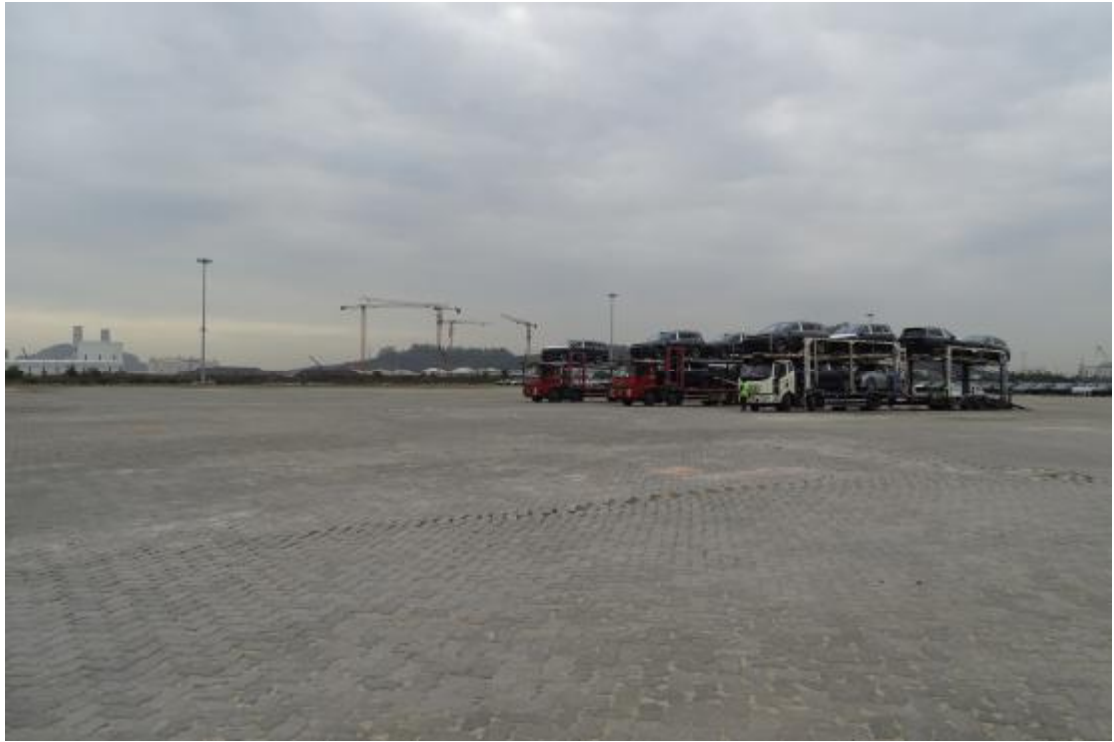
图 11 项目用地地表现状（北-南）
