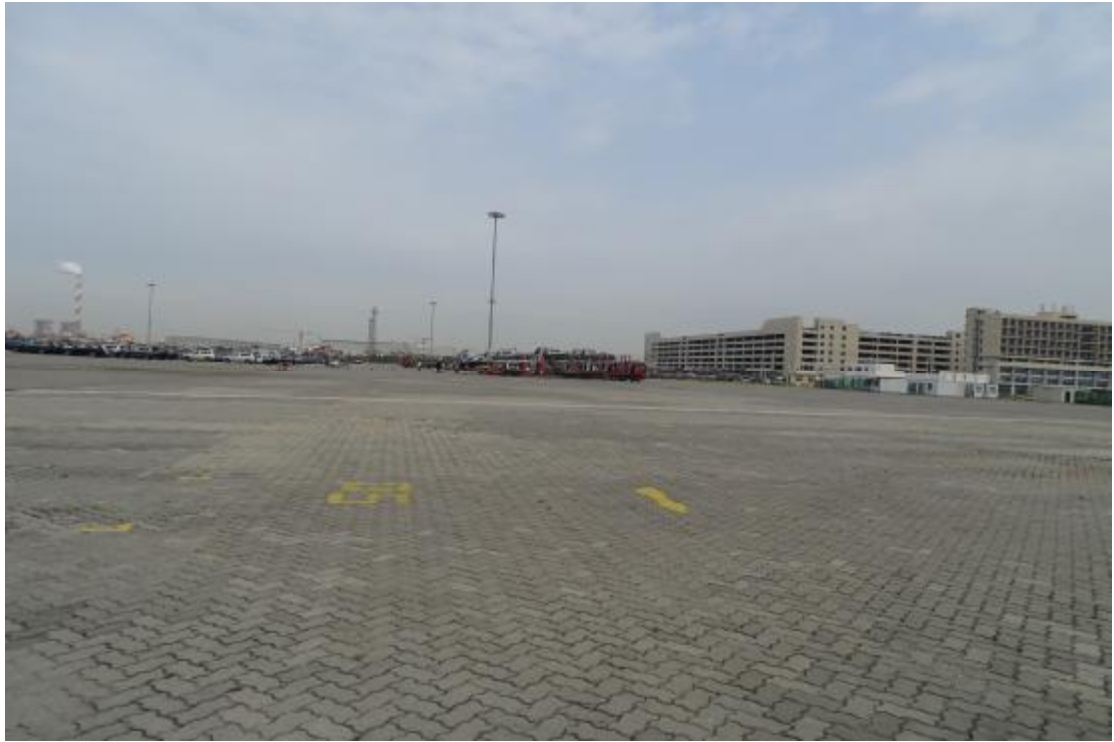
图 39 项目用地地表现状（南-北）
