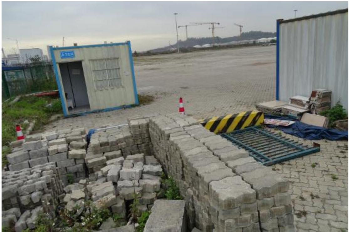
图 10 项目用地地表现状（北-南）
