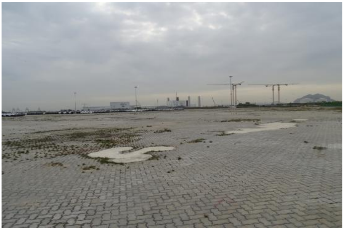
图 22 项目用地地表现状（北-南）
