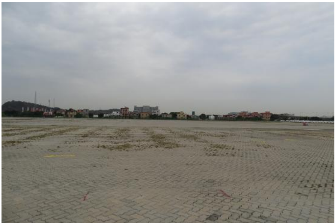
图 16 项目用地地表现状（北-南）
