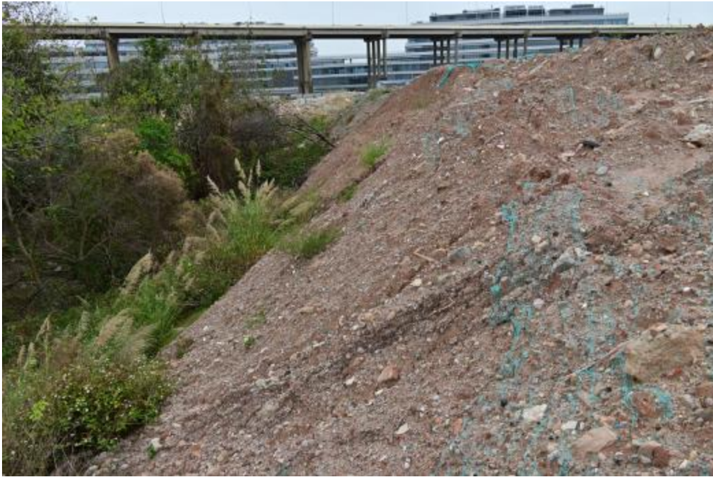
图 18 地块内西部现状（北-南）
