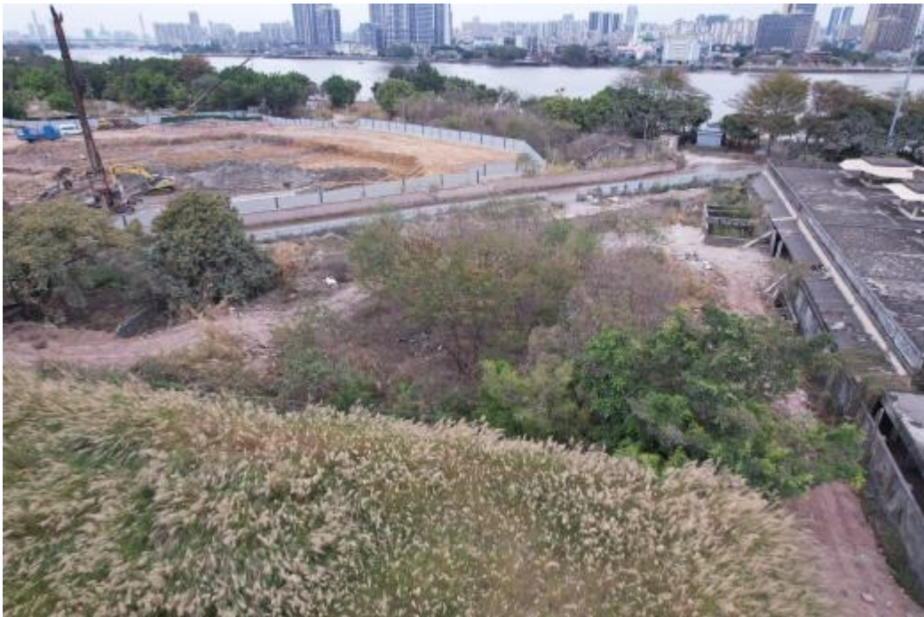
图 15 地块内北部现状（南-北）
