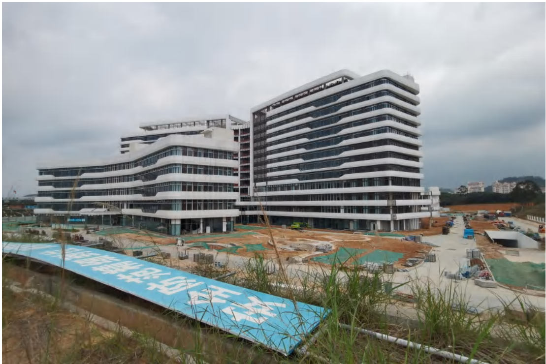
图 8 地块外北侧现状（西南-东北）
