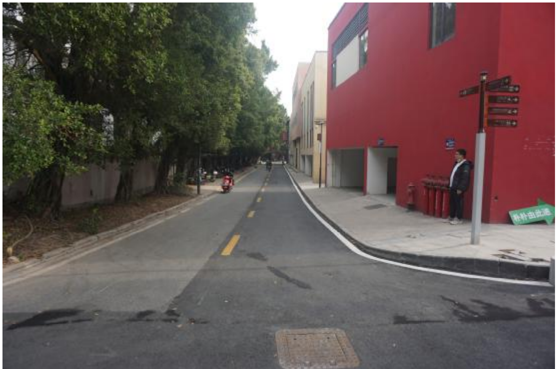
图 29 地块周边地貌照（西南-东北）
