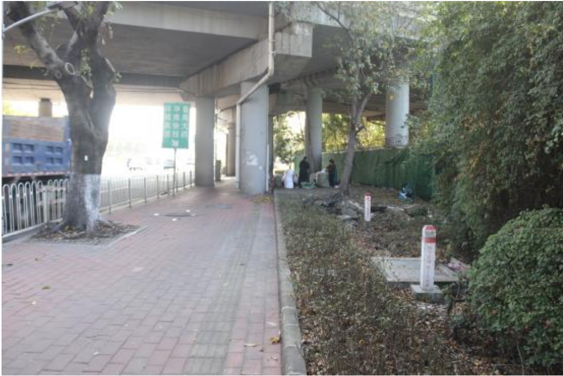
图 20 地块内部现状（北-南）
