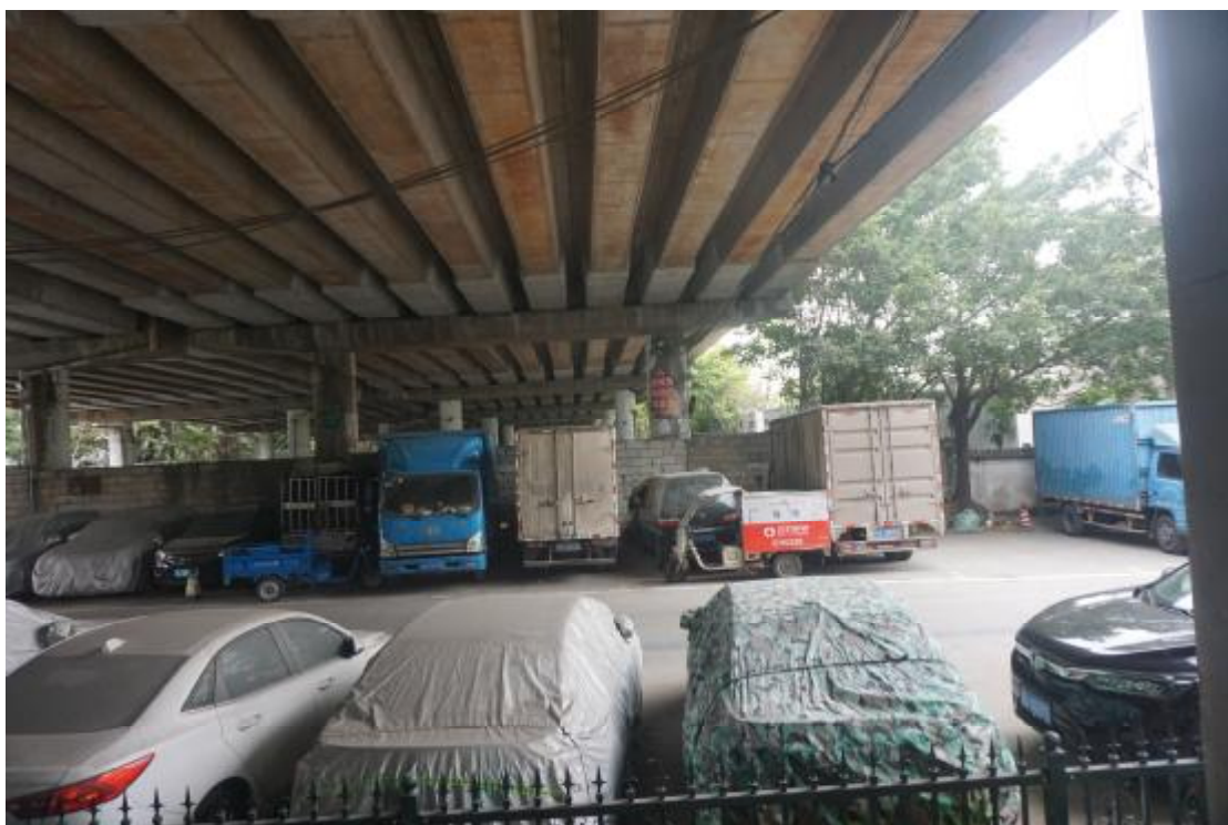
图 19 地块内部现状（北-南）
