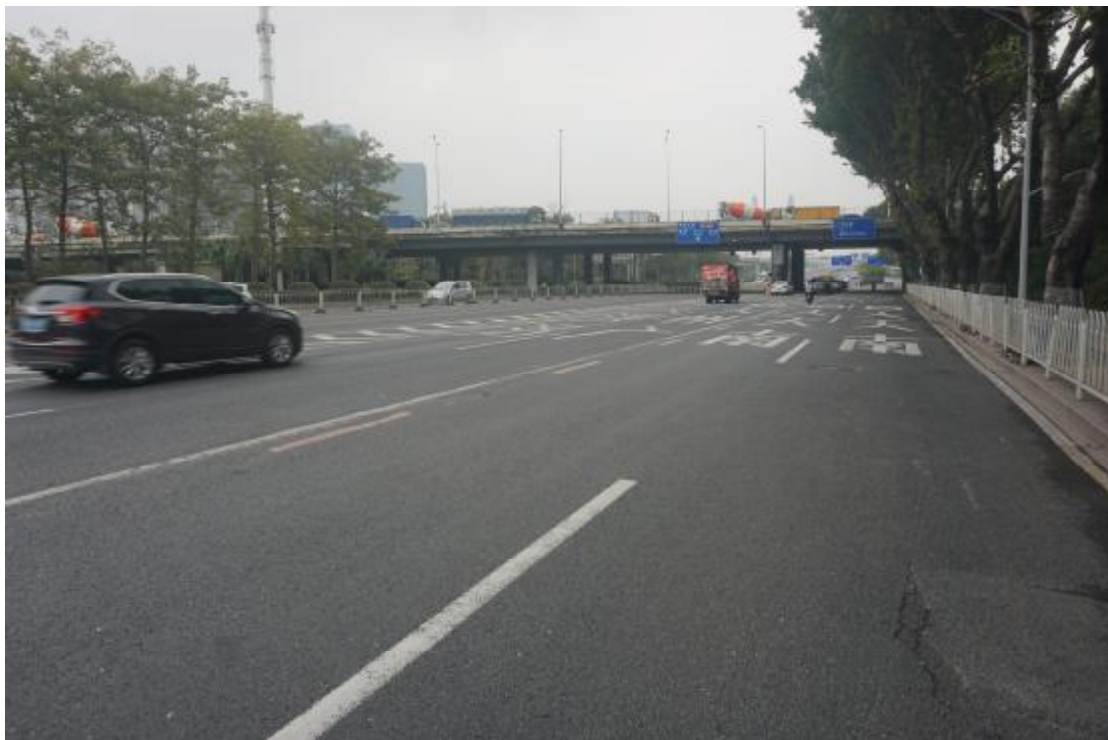
图 18 地块内部现状（北-南）
