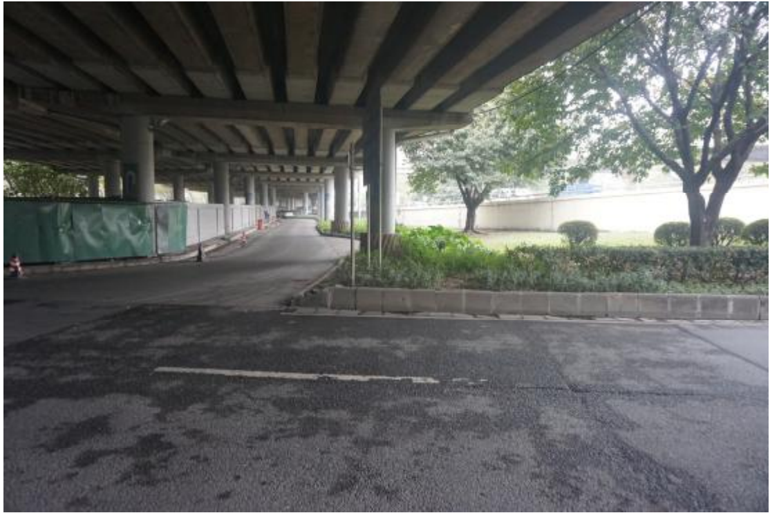
图 24 地块内部现状（东-西）
