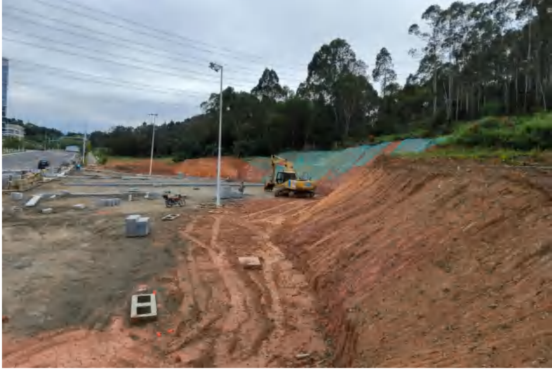
图 14 地块地表现状（西-东）
