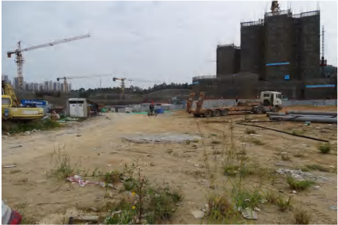
图 12 地块地表现状（西-东）
