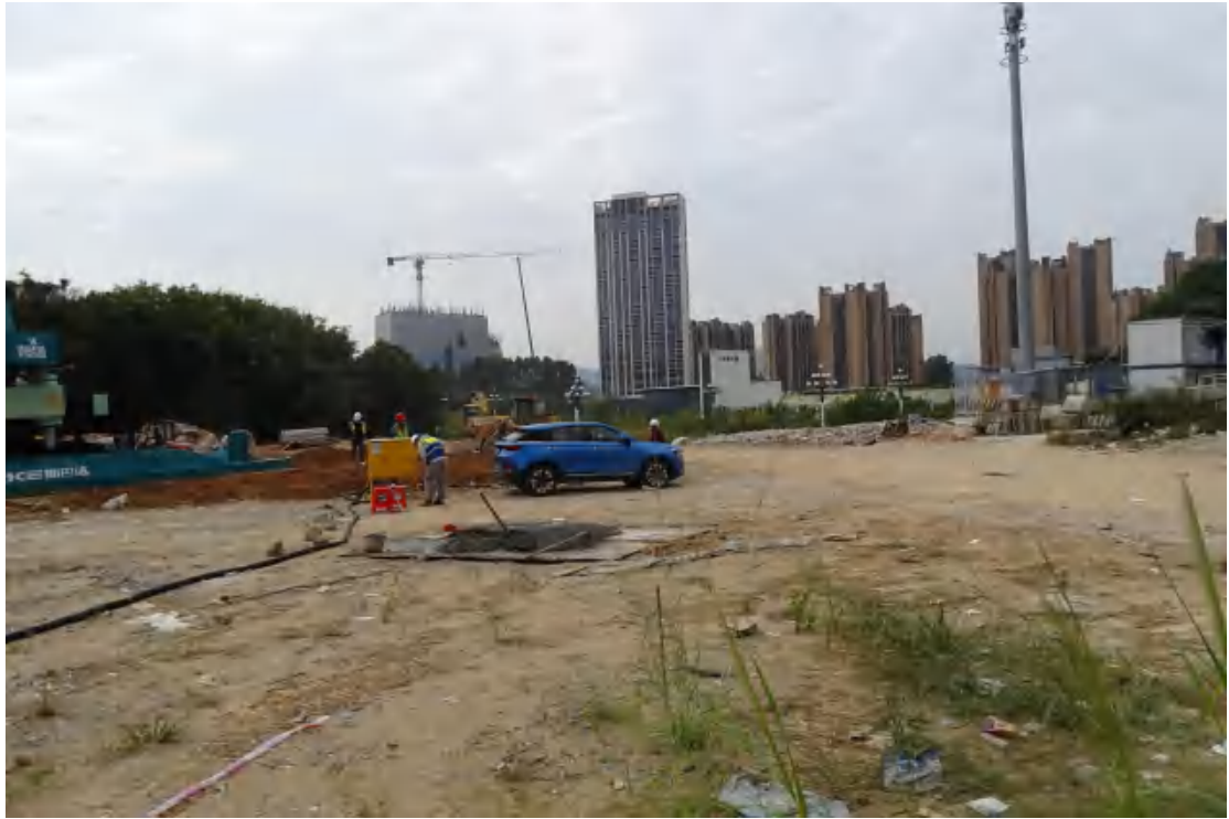
图 14 地块地表现状（东-西）
