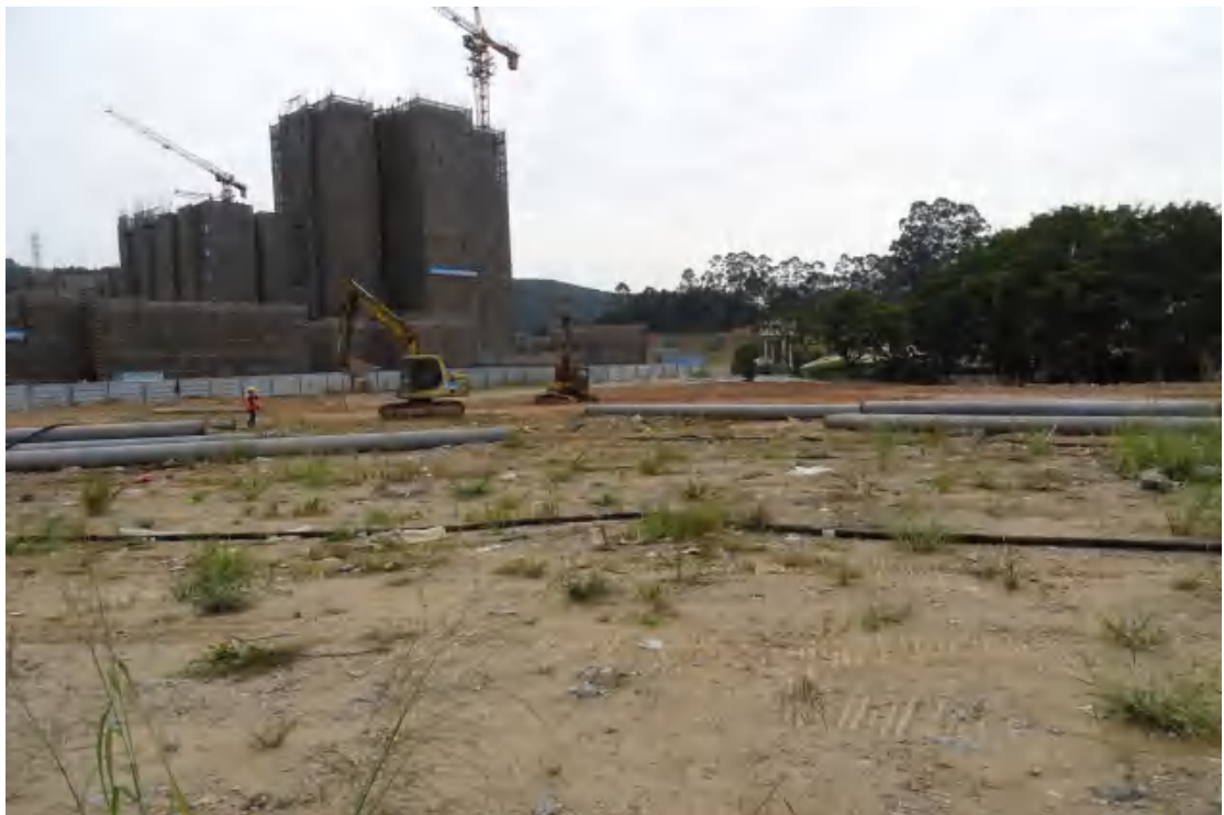
图 13 地块地表现状（北-南）
