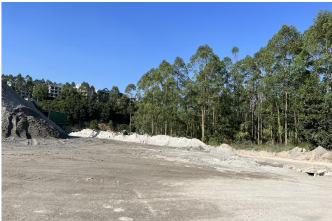
图 10 地块地表现状（南-北）
