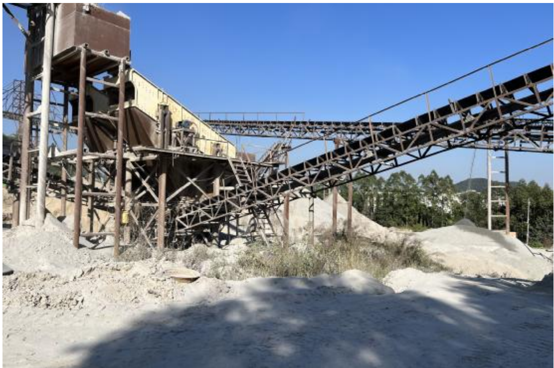
图 18 地块地表现状（西-东）
