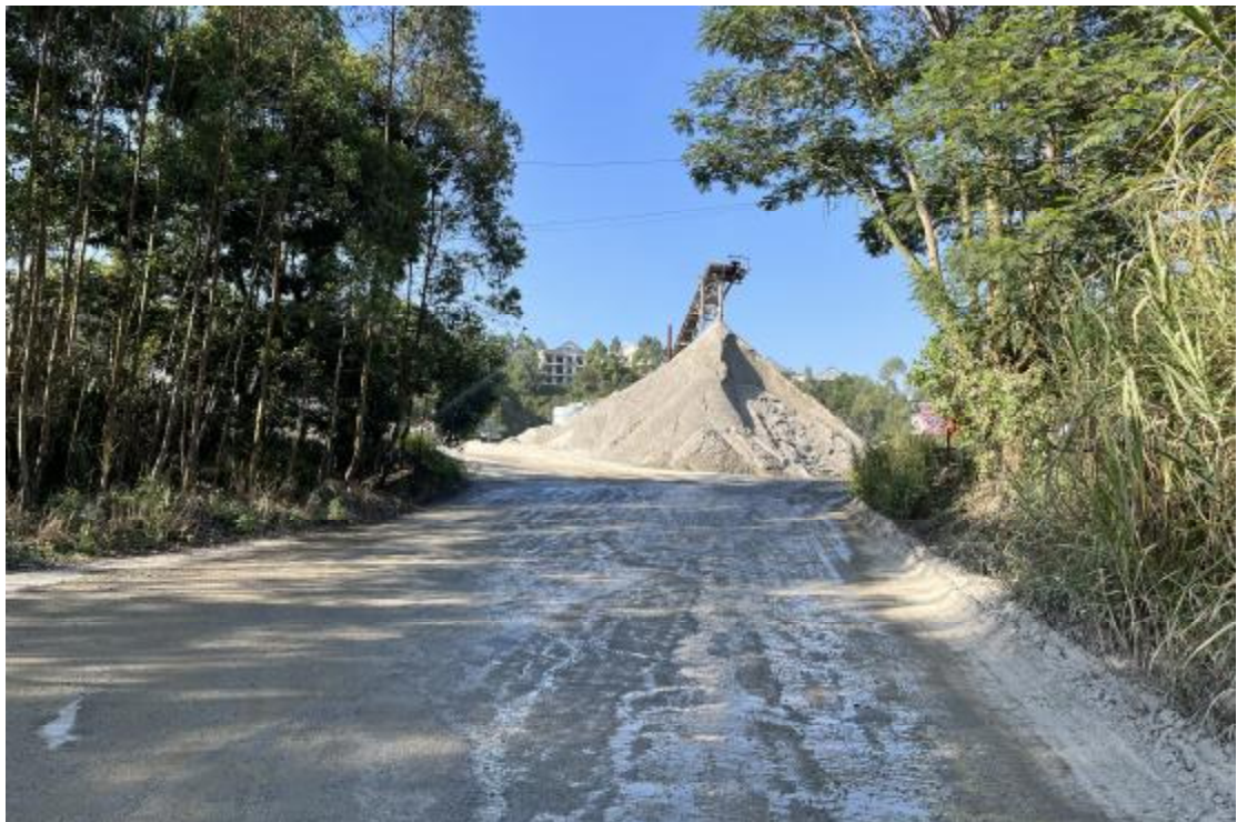
图 22 地块地表现状（南-北）
