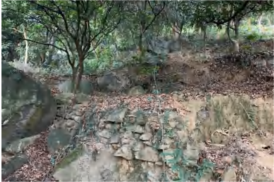
图 9 地块内现状（东北-西南）
