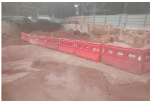
图 15 工地现场围挡
