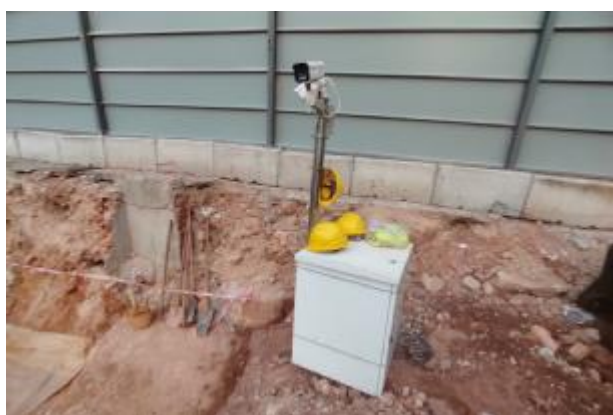
图 19 工地监控设备
