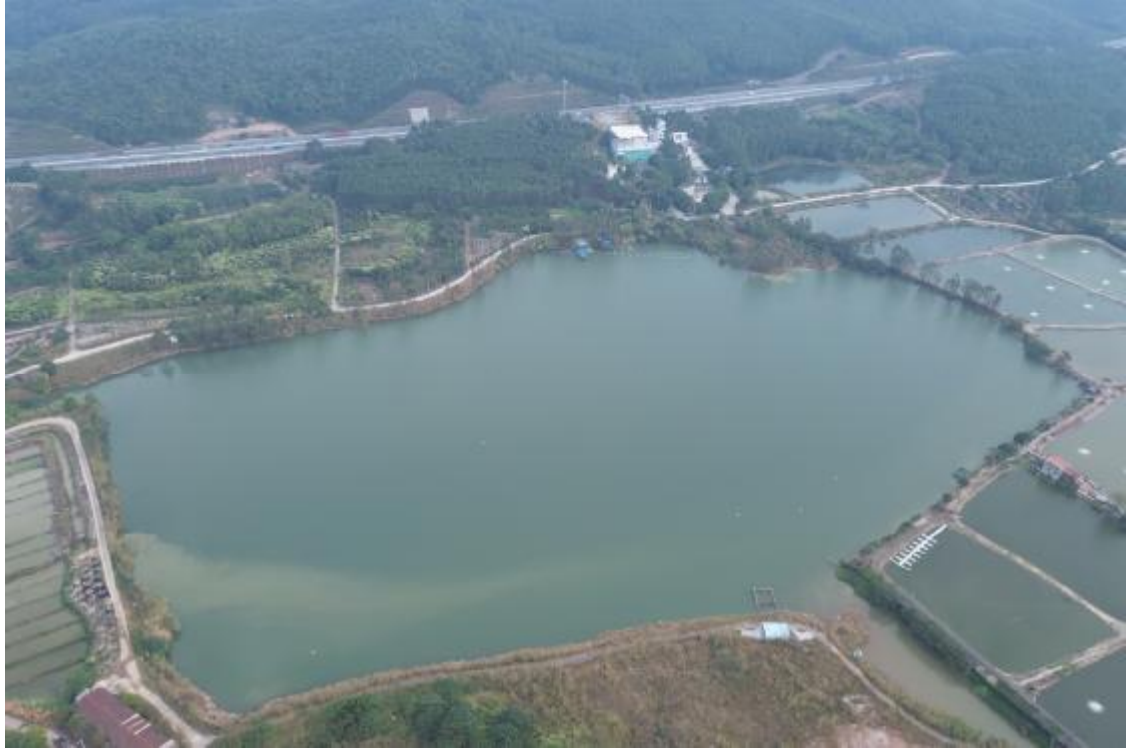
图 15 项目地块东南部现状（西北-东南）
