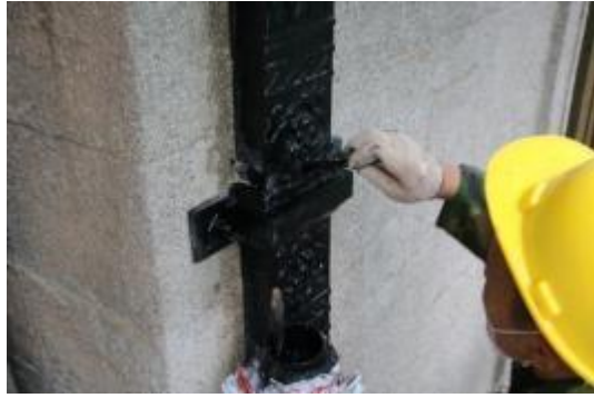
铁艺修复施工照片
