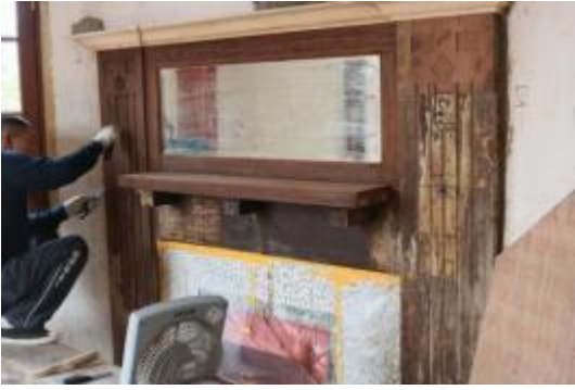
壁炉修复施工照片
