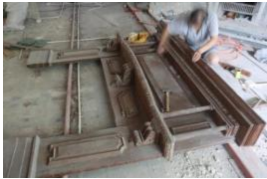
壁炉修复施工照片
