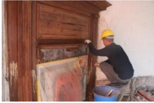
壁炉修复施工照片
