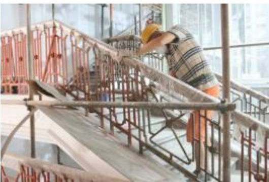
铁艺修复施工照片
