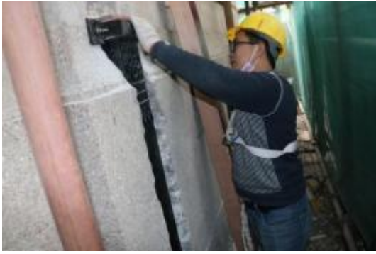
铁艺修复施工照片
