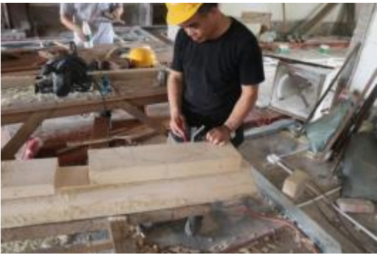
壁炉修复施工照片
