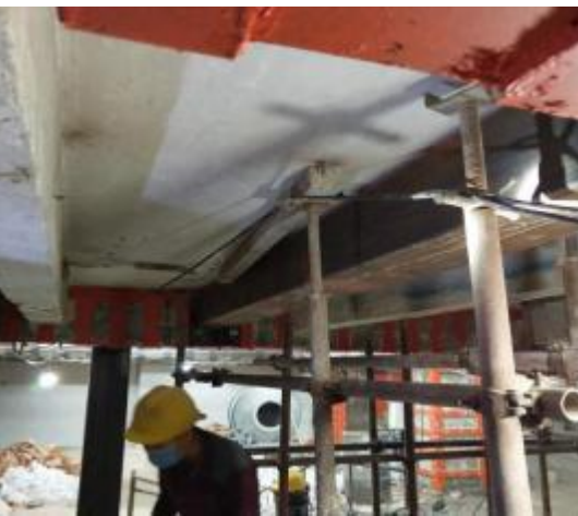
地下室加固施工照片
