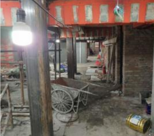
地下室加固施工照片
