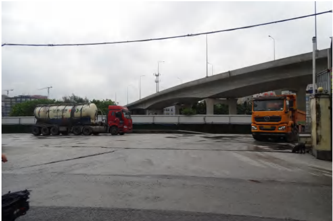
图 22 工程用地南部地表现状（东-西）
