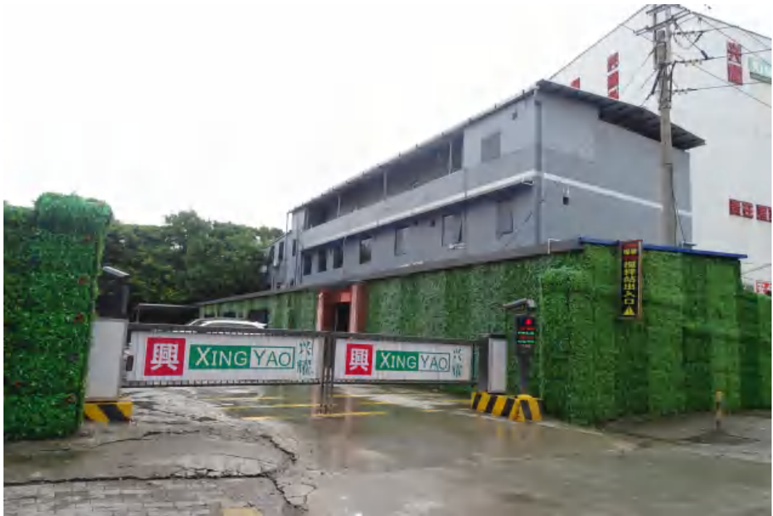
图 19 工程用地南部地表现状（东-西）
