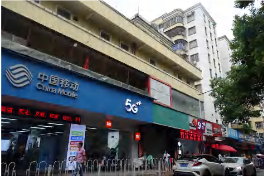
图 11 工程用地北部地表现状（南-北）
