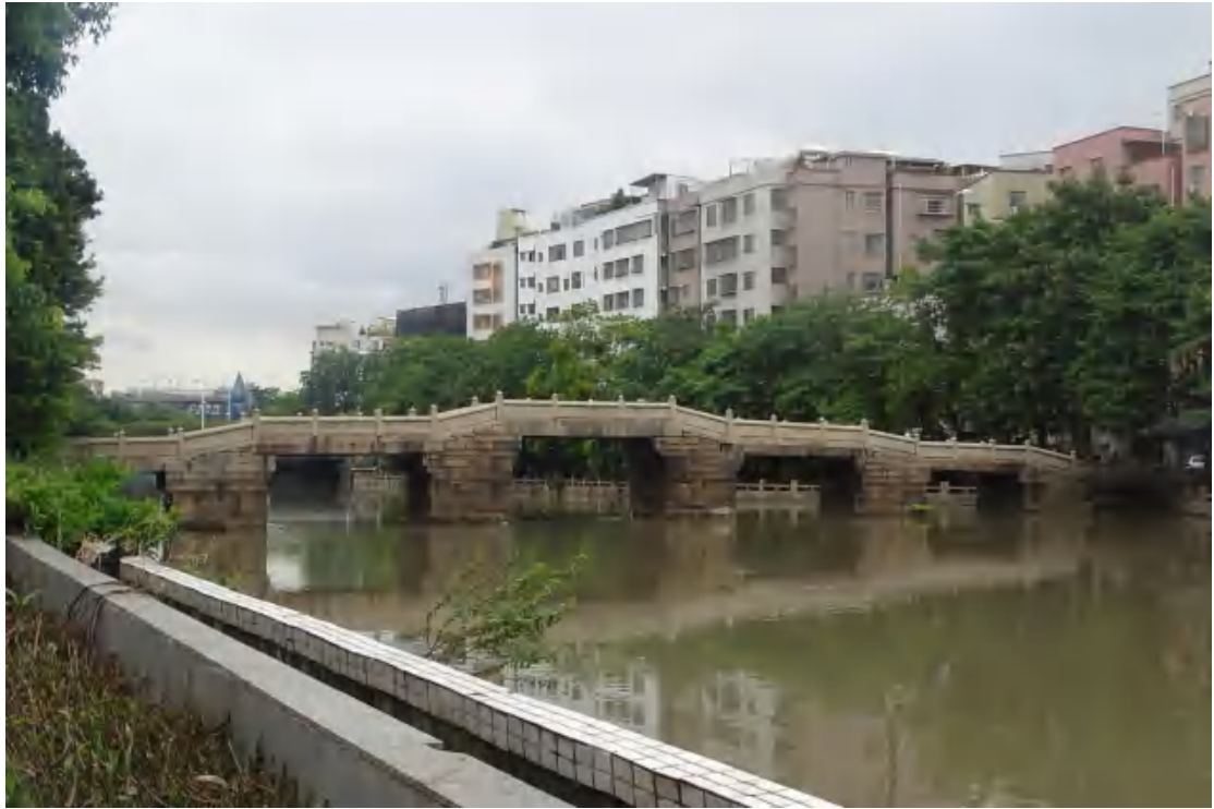
图 15 工程用地北部地表现状（南-北）
