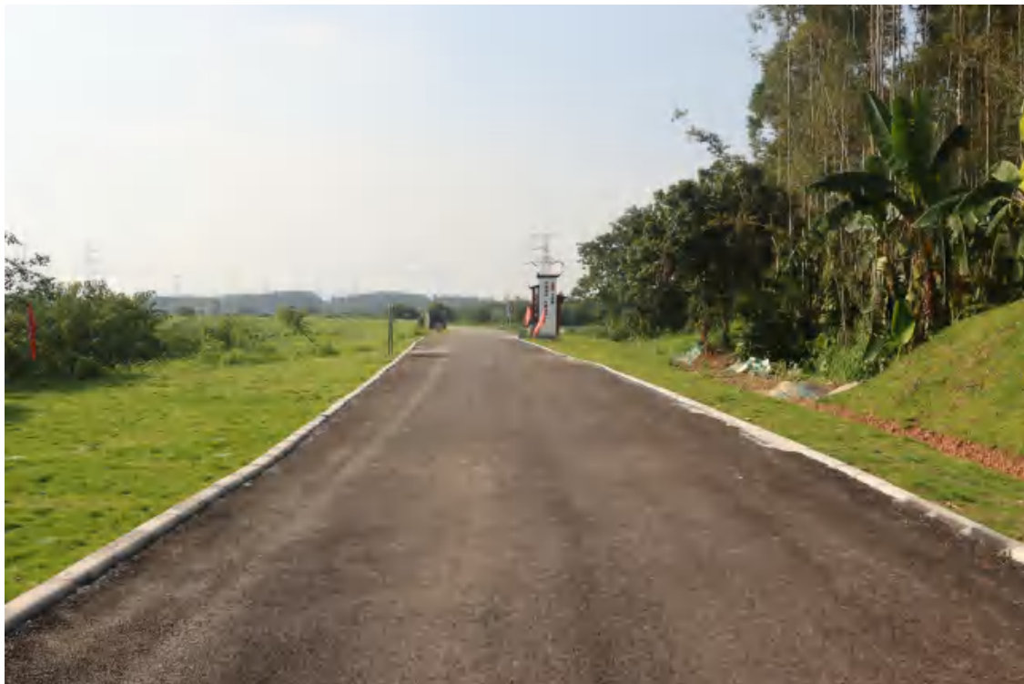
图 17 地块内部现状（南-北）
