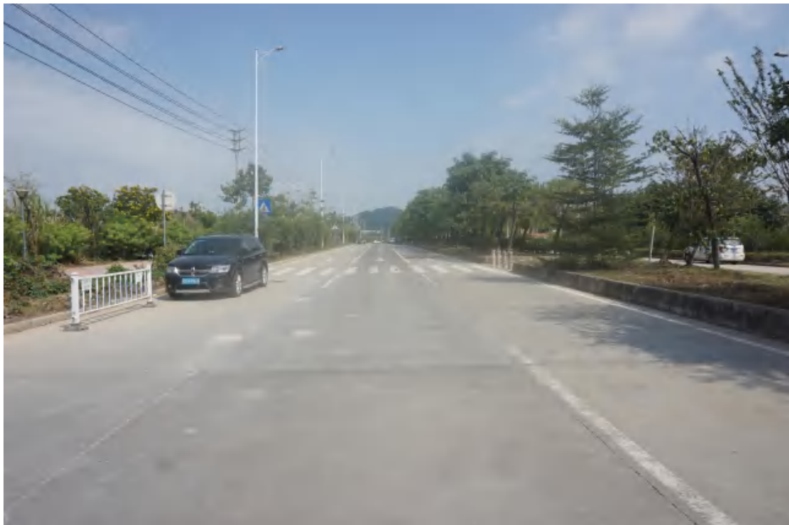
图 19 地块内部现状（南-北）
