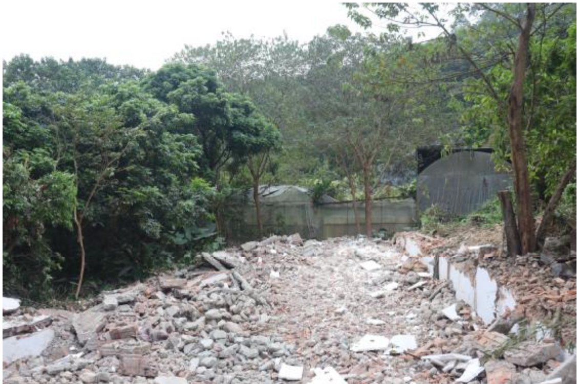
图 24 地块中部地貌（东-西）
