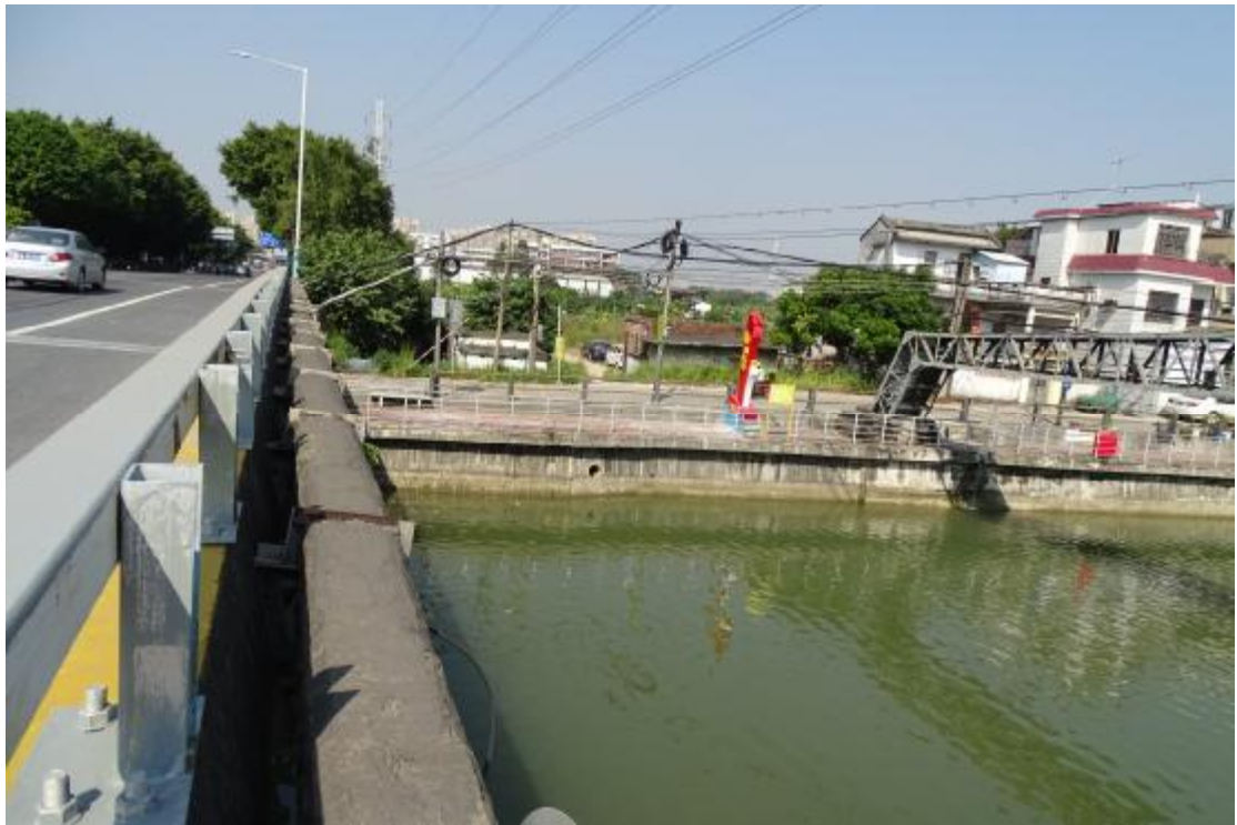
图 11 工程用地地表现状（东—西）
