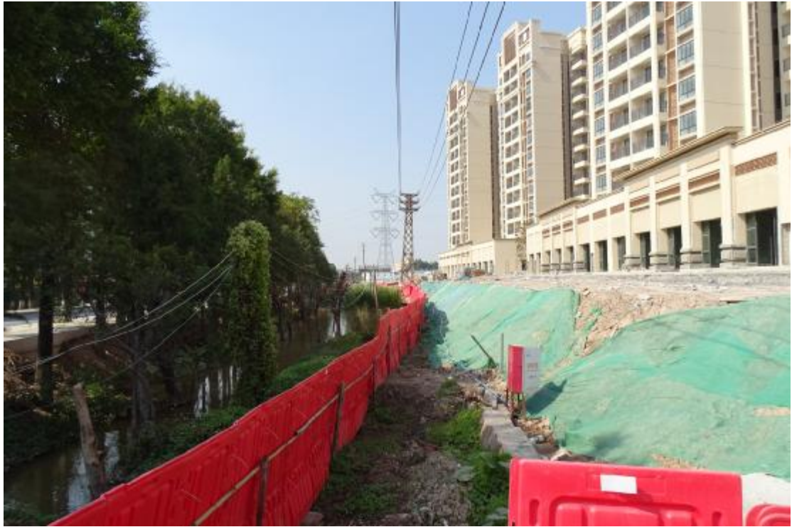
图 24 工程用地地表现状（东—西）
