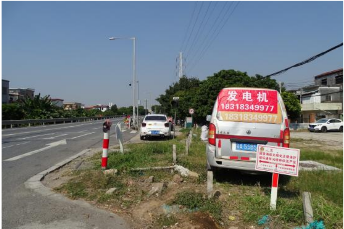
图 8 工程用地地表现状（东—西）
