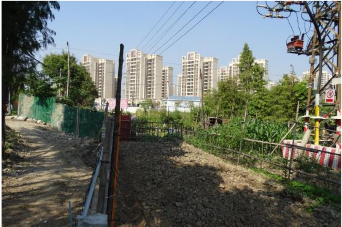
图 22 工程用地地表现状（东—西）
