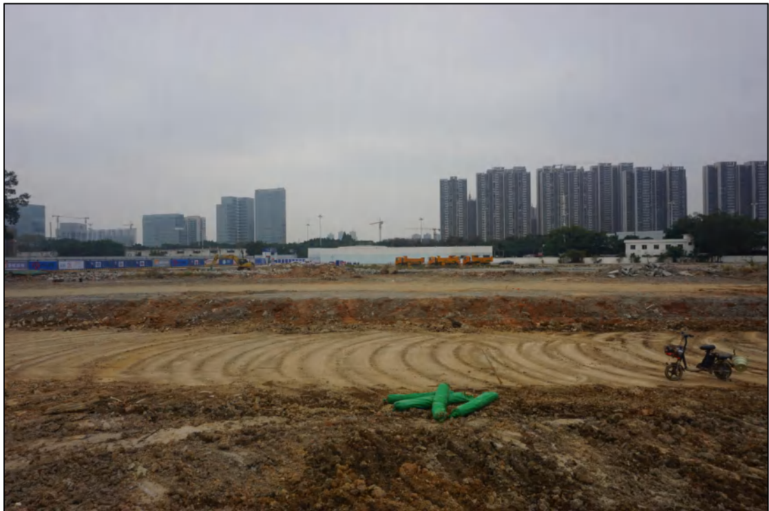
图 30 项目地块南部地貌（北-南）
