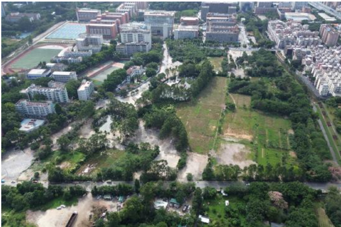
图 19 地块内部现状（航拍）
