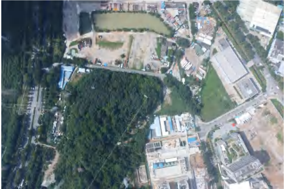
图 6 航拍全景（上北-下南）
