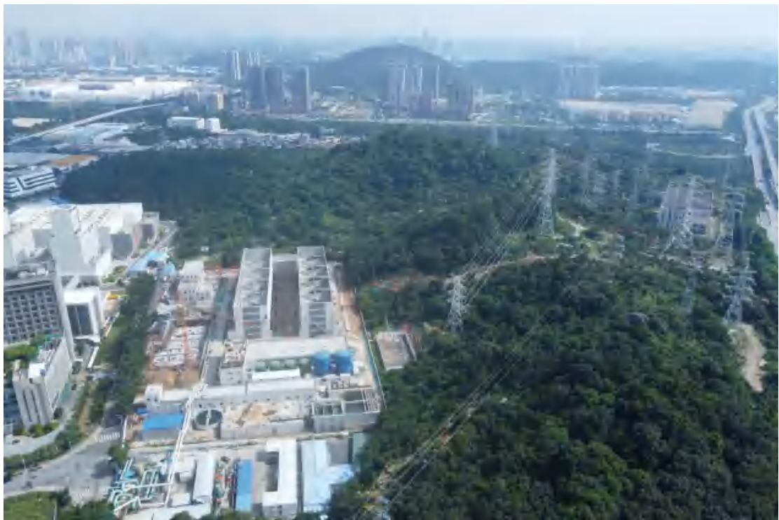
图 9 地块外南部现状（北-南）
