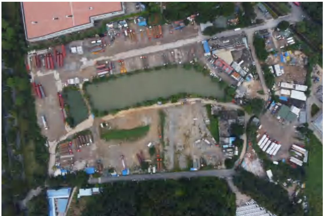
图 11 地块内北部现状（上北下南）
