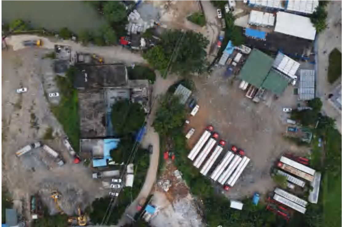
图 14 地块内北部现状（上北下南）
