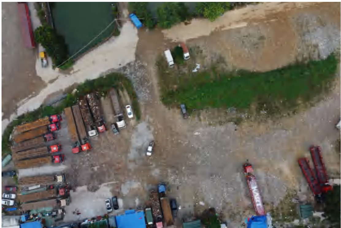
图 15 地块内北部现状（上北下南）
