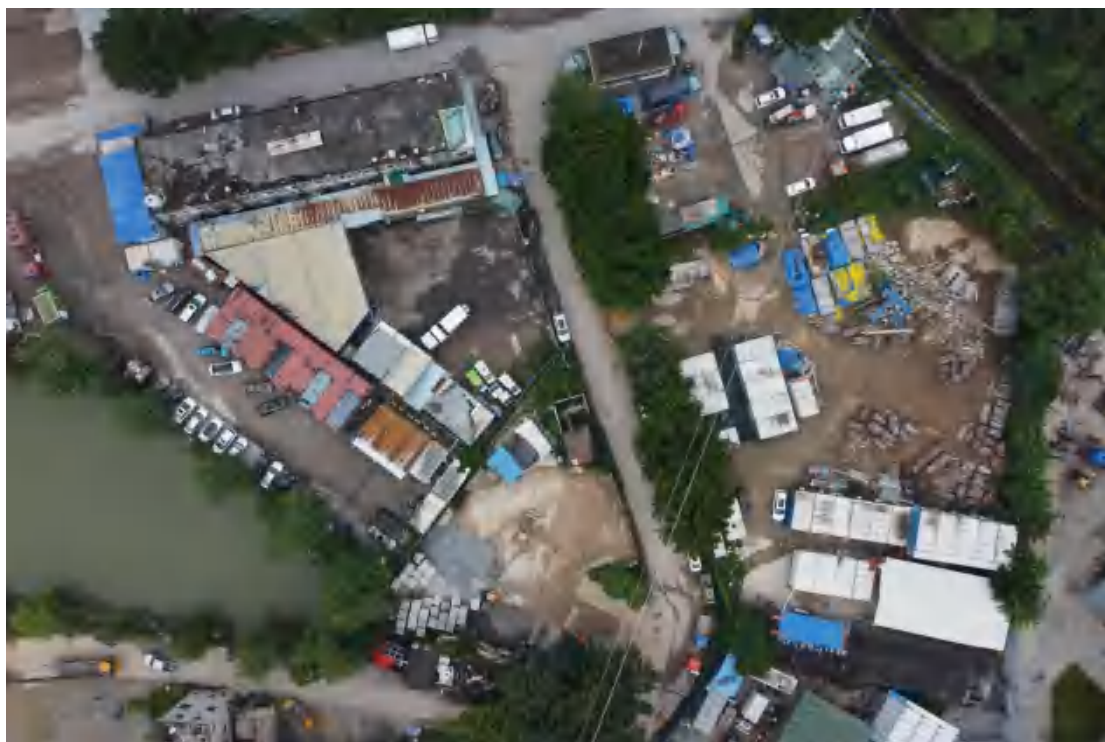
图 13 地块内北部现状（上北下南）
