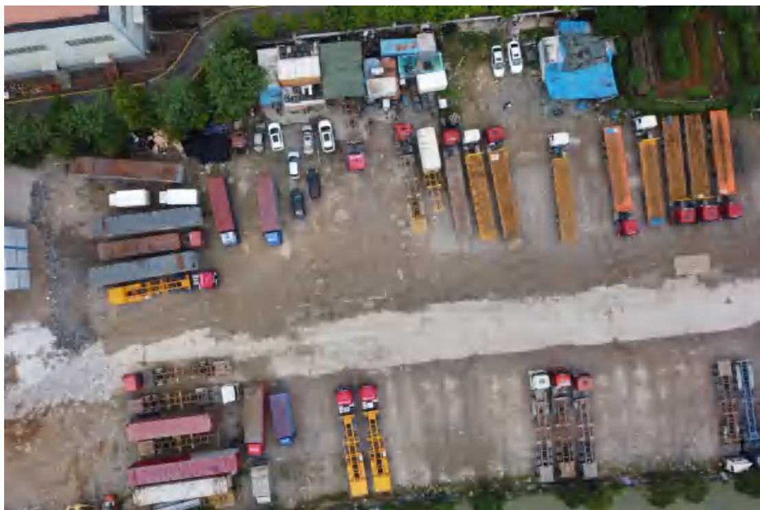
图 12 地块内北部现状（上北下南）
