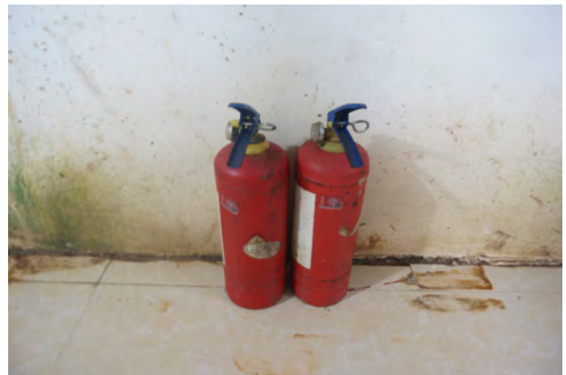
图 24 发掘现场消防器材
