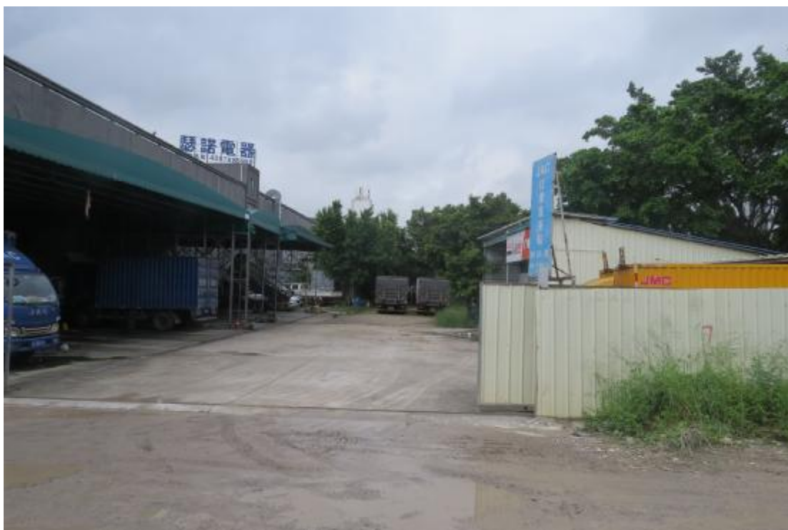
图 16 项目地块东南部现状（东-西）
