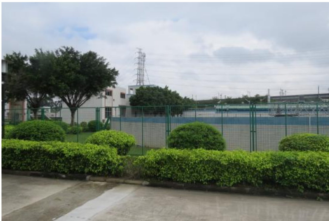
图 14 北部钟村净水厂现状（西南-东北）
