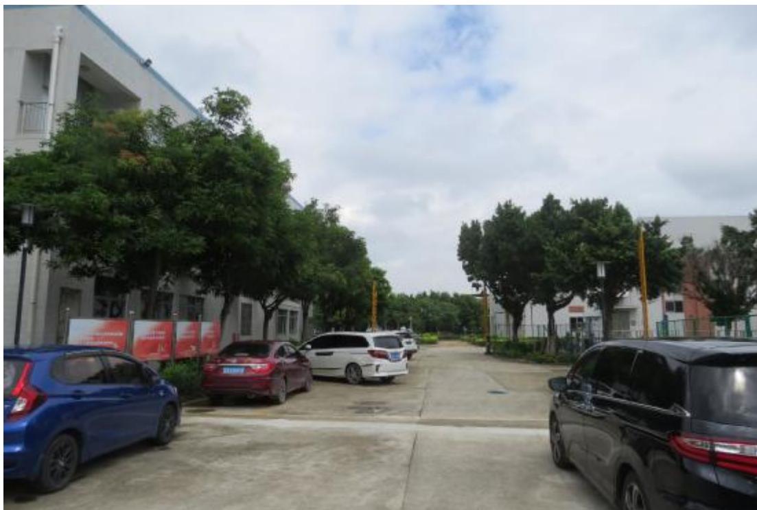
图 13 北部钟村净水厂现状（东南-西北）
