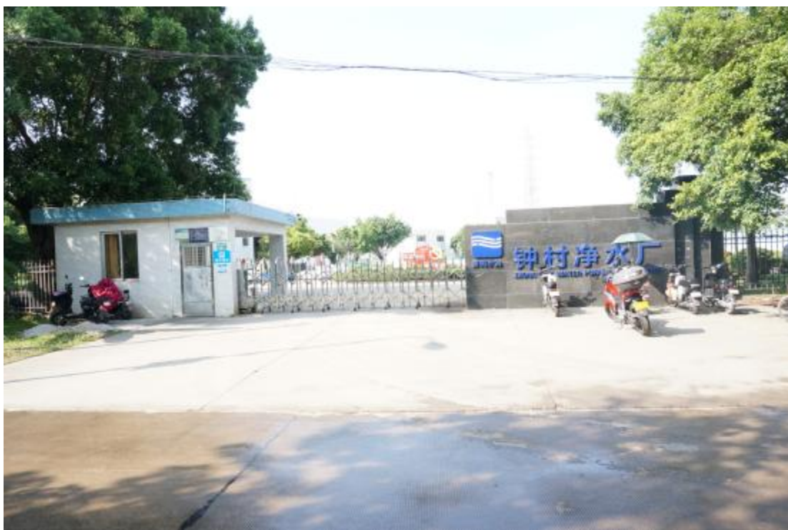
图 10 北部钟村净水厂大门（南-北）
