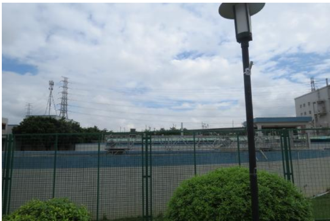
图 12 北部钟村净水厂现状（东-西）
