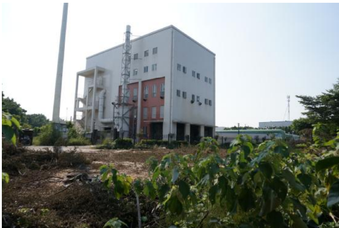
图 11 北部钟村净水厂现状（东南-西北）
