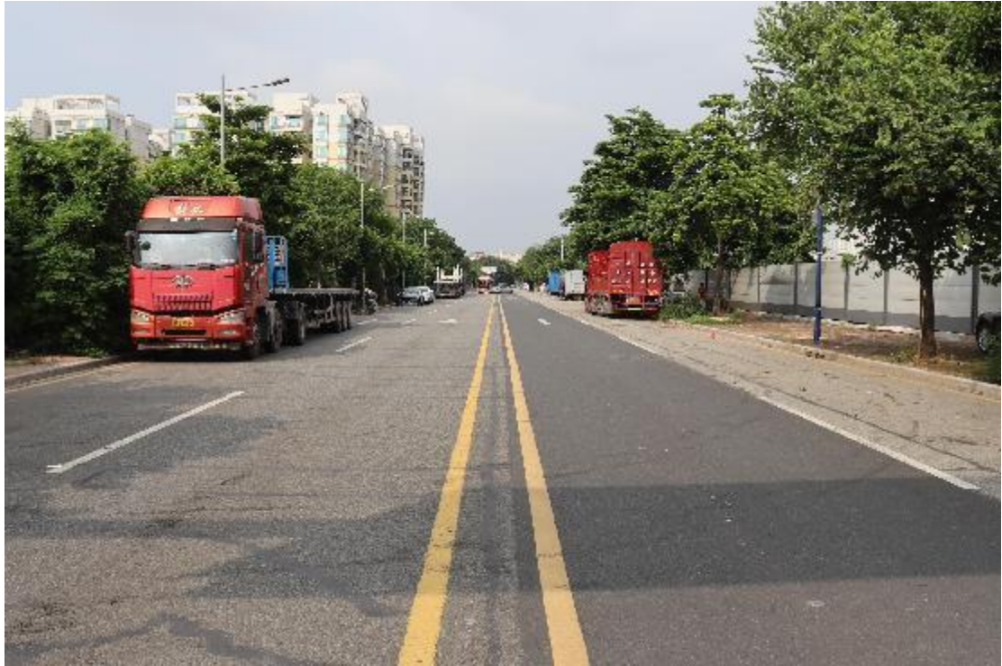
图 22 地块内西部现状（东-西）
