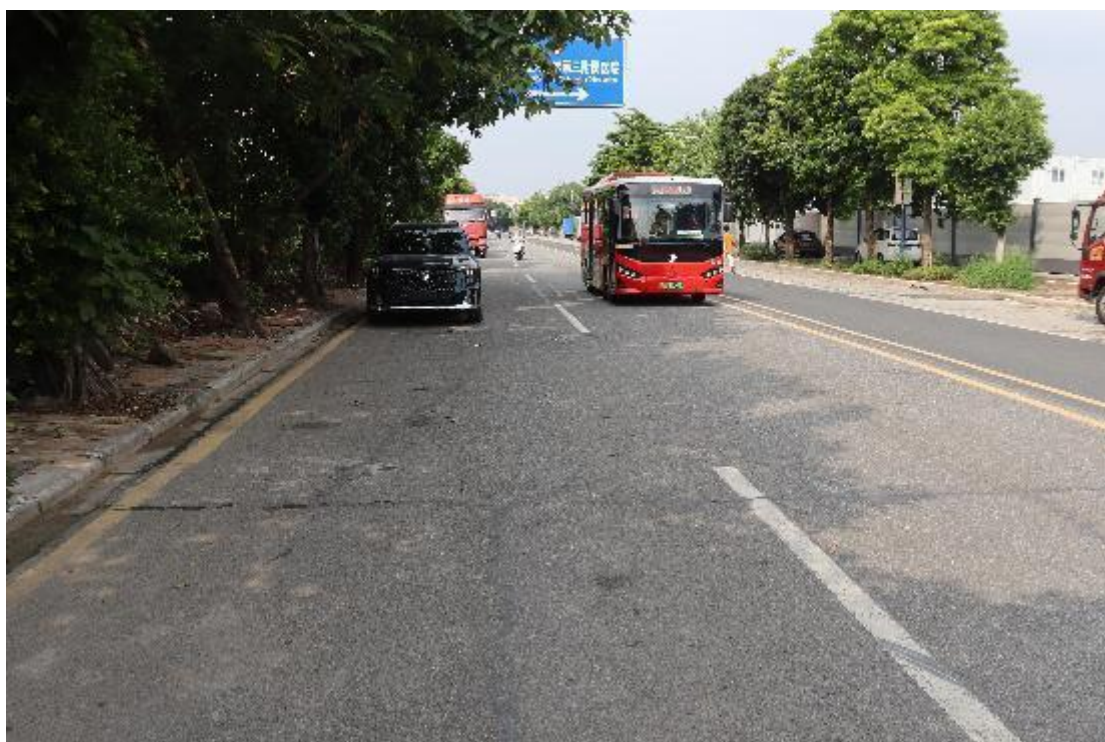
图 21 地块内西部现状（东-西）
