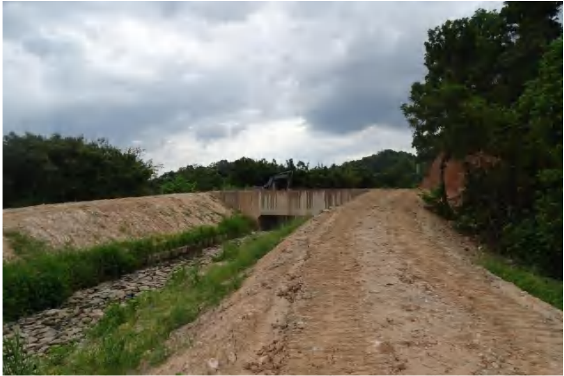
图 14 地块西部地表现状（西—东）
