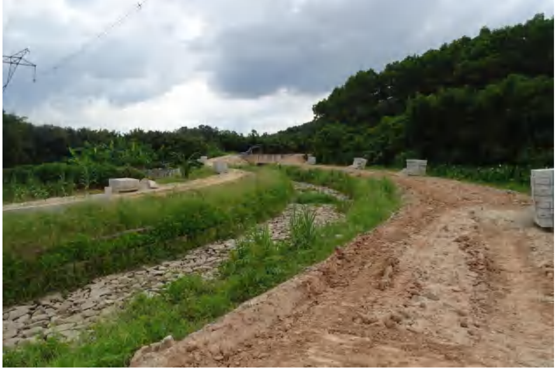
图 12 地块西部地表现状（西—东）
