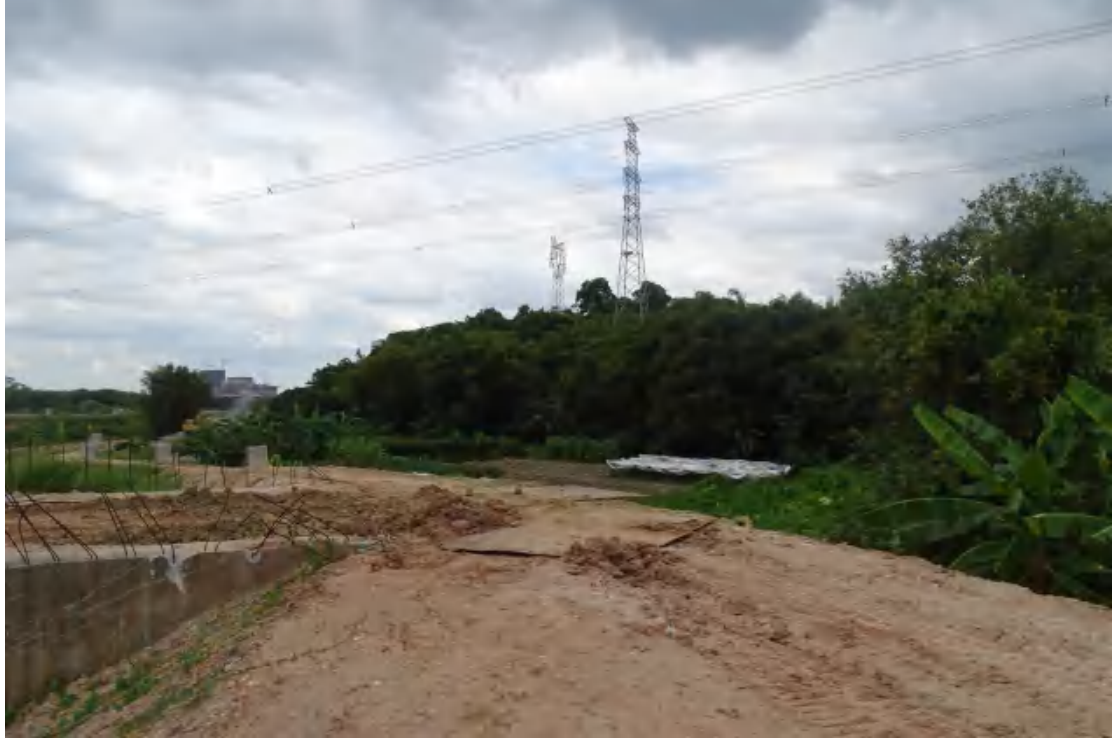
图 16 地块西部地表现状（东—西）
