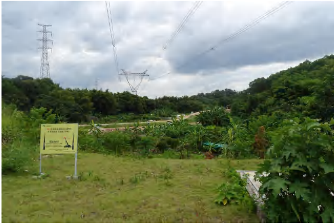
图 8 地块西部地表现状（西—东）
