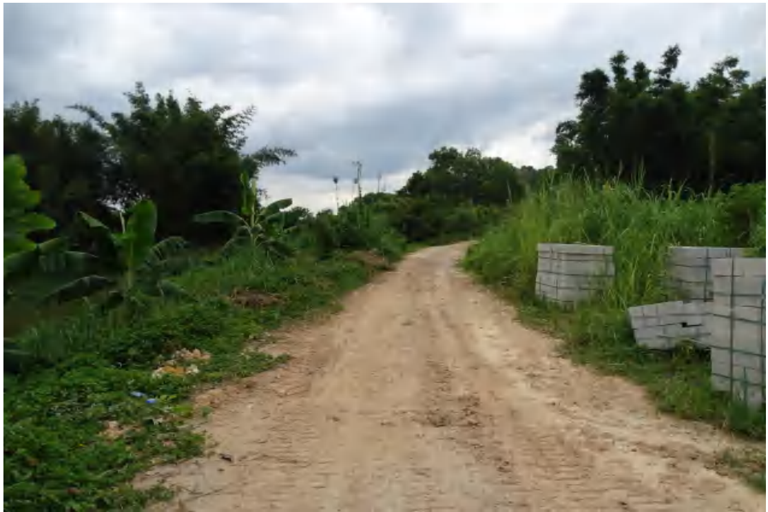
图 17 地块西部地表现状（西—东）
