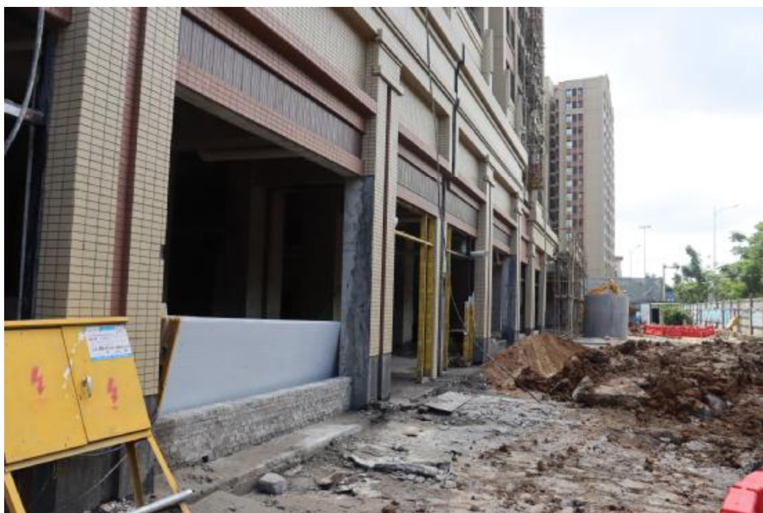
图 14 地块内东部现状（西北-东南）
