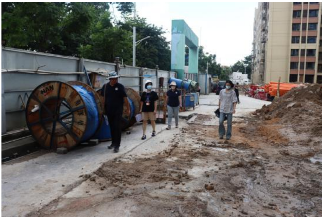
图 10 现场踏查（东-西）
