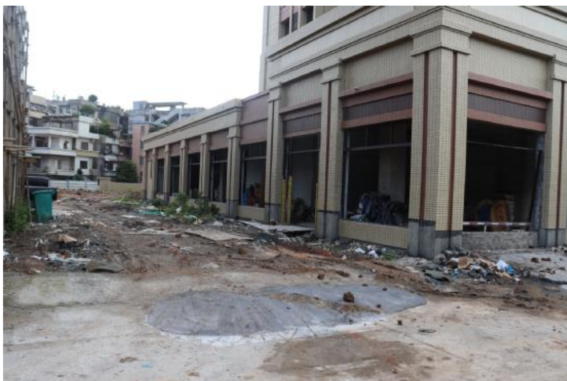
图 15 地块内中部现状（南-北）
