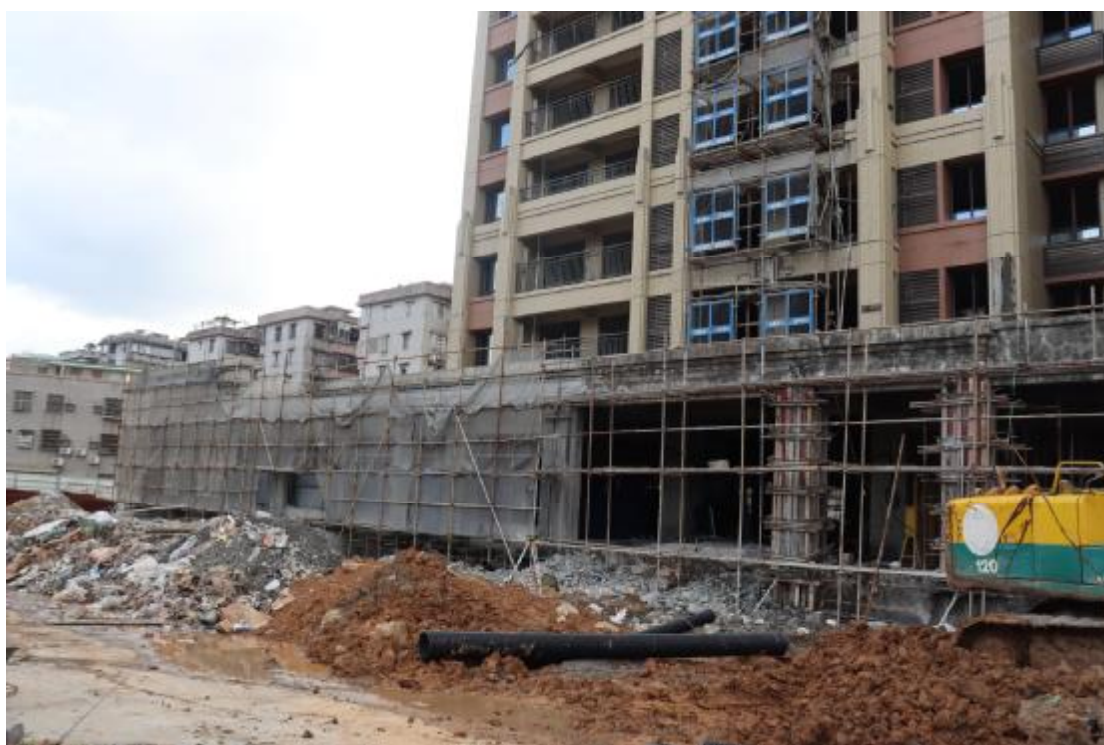
图 19 地块内西部现状（西南-东北）
