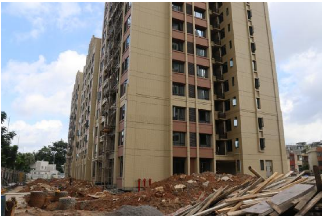
图 17 地块内西部现状（东南-西北）
