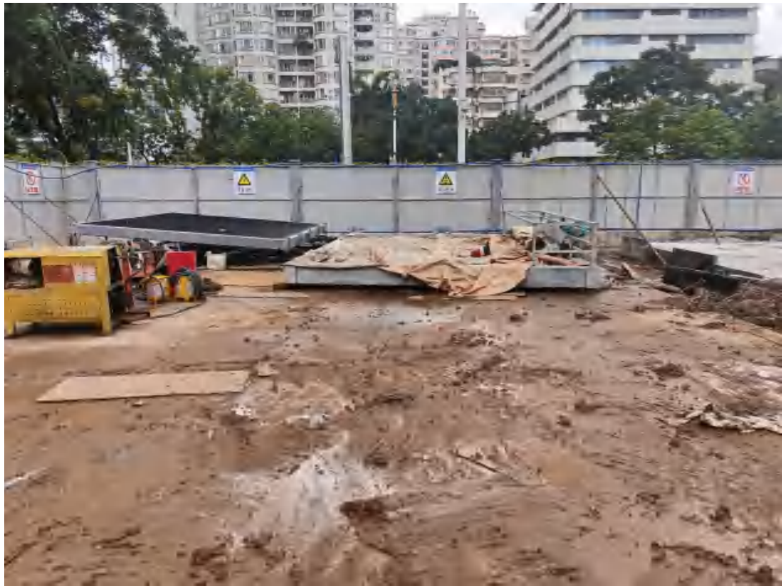
图 27 勘探区域地表（东南-西北）
