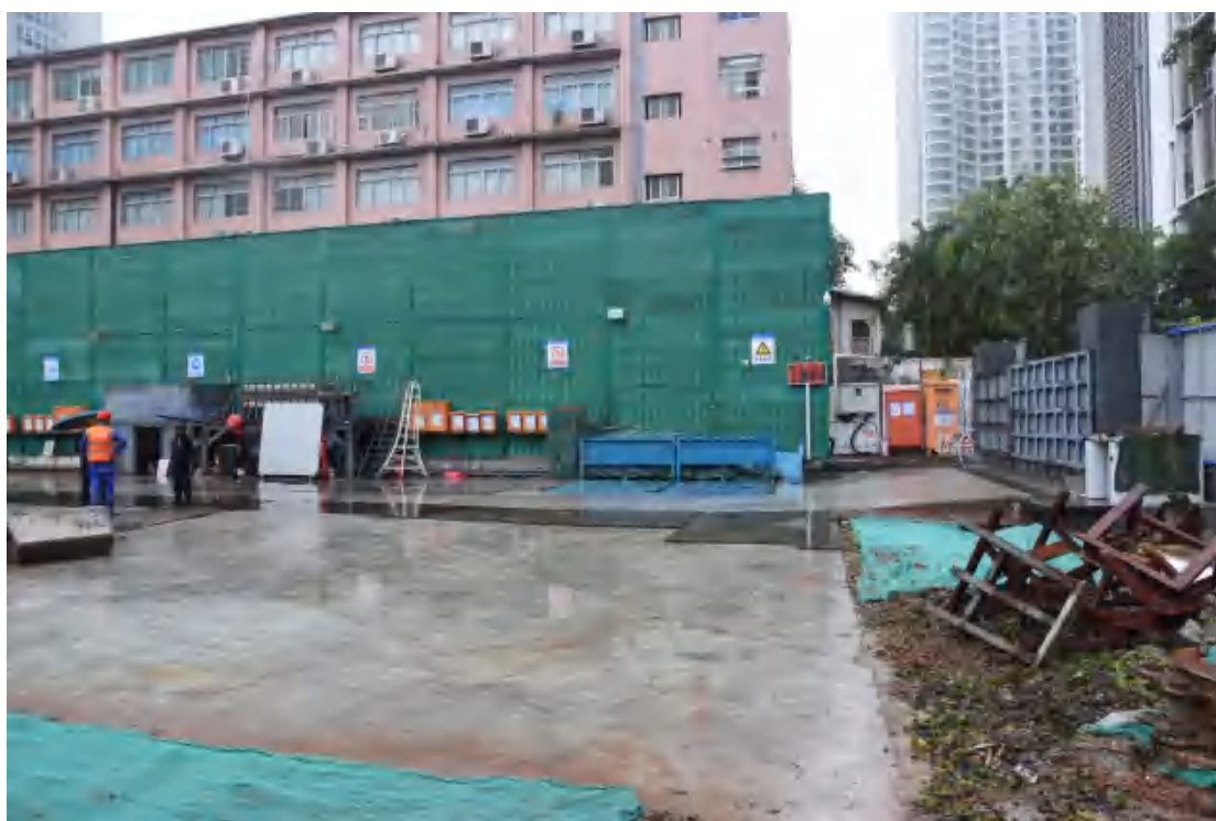
图 19 A 出入口及 1 号风亭地块现状（北-南）
