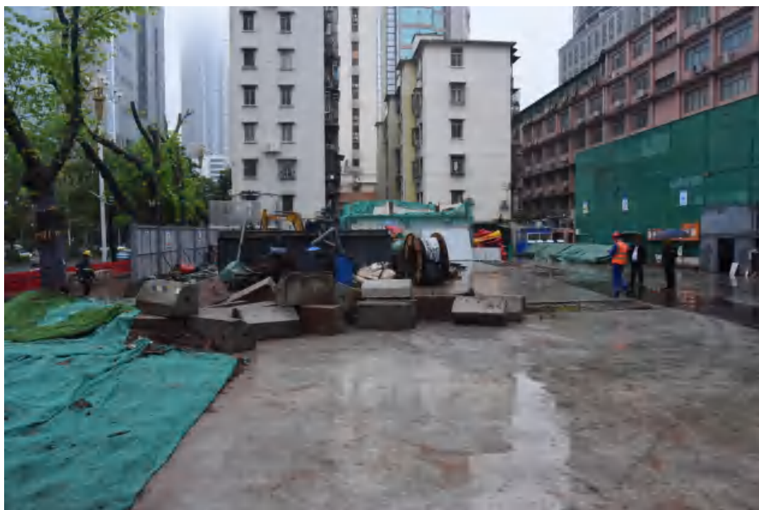
图 16 A 出入口及 1 号风亭地块现状（西-东）
