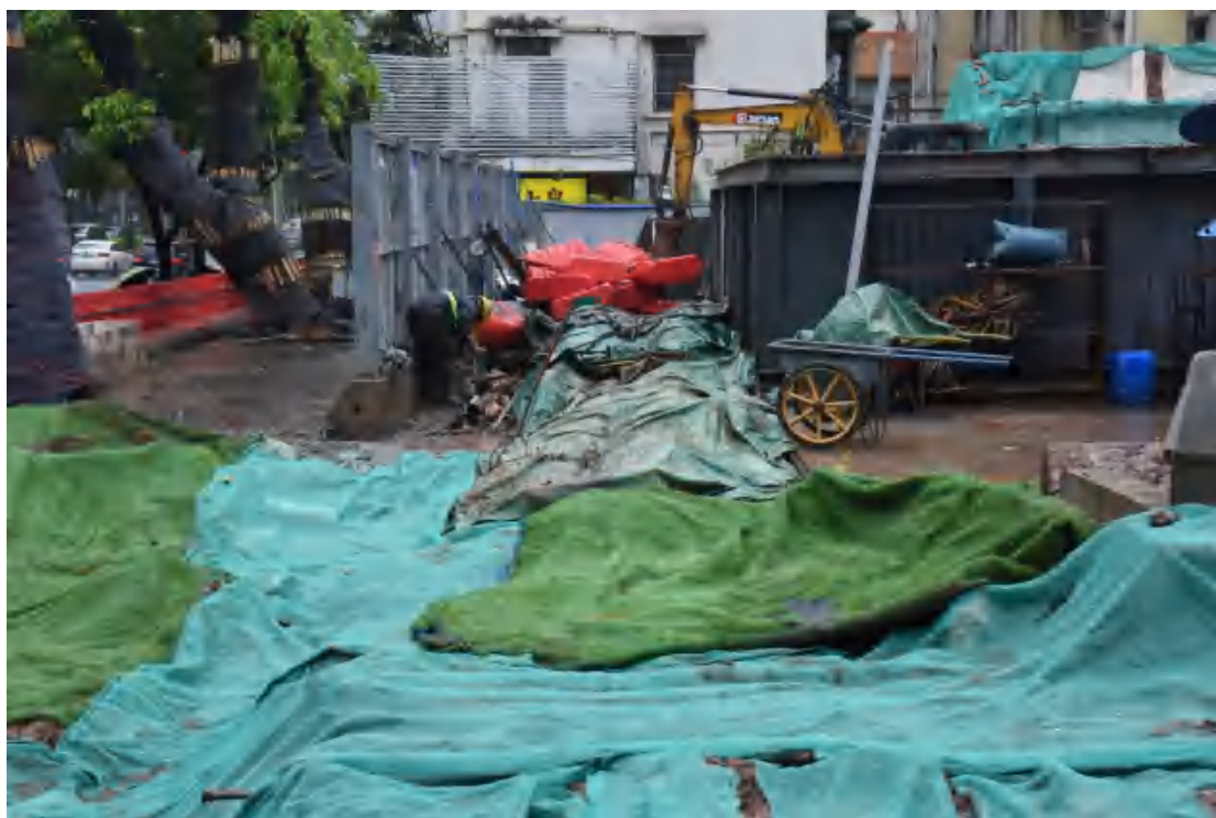
图 17 A 出入口及 1 号风亭地块现状（西-东）
