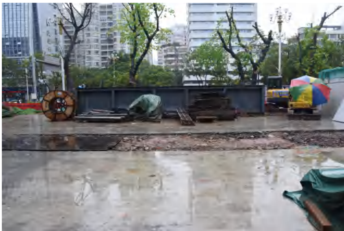
图 18 A 出入口及 1 号风亭地块现状（北-南）
