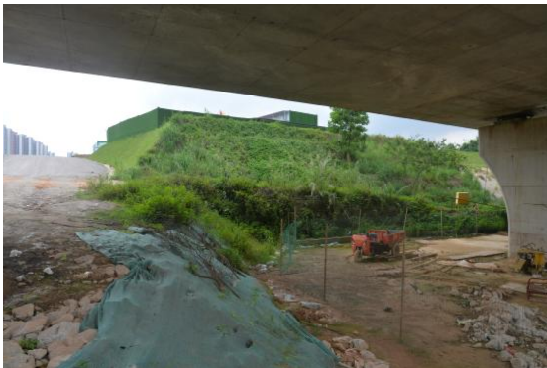
图 49 工程用地地表现状（东—西）
