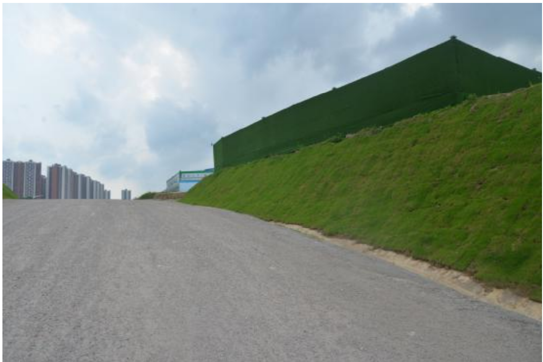
图 44 工程用地地表现状（东—西）
