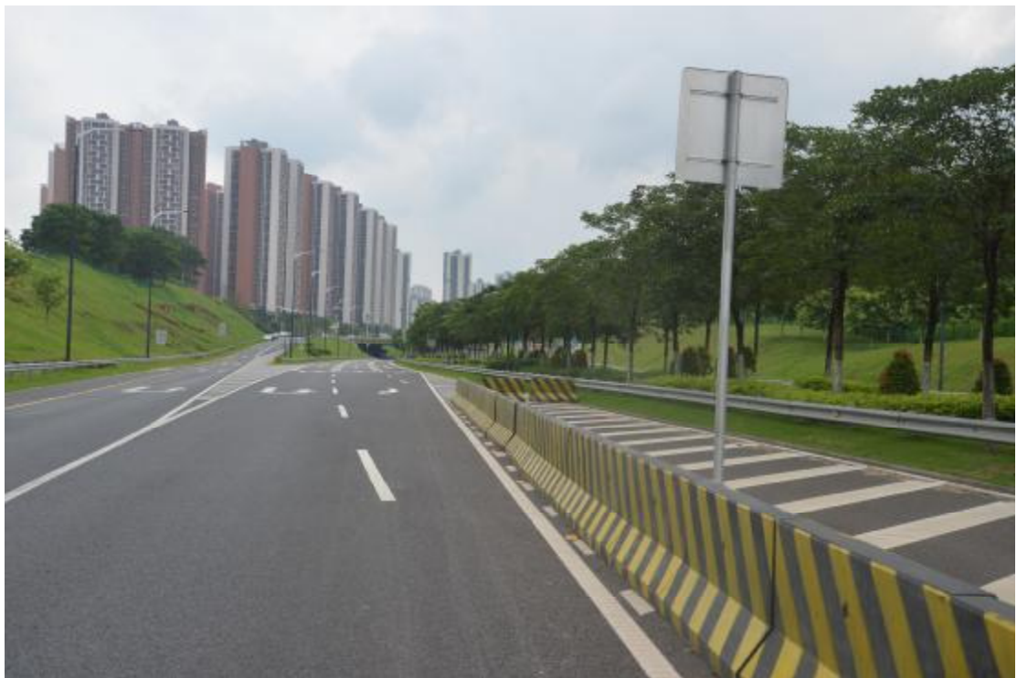
图 32 工程用地地表现状（东—西）
