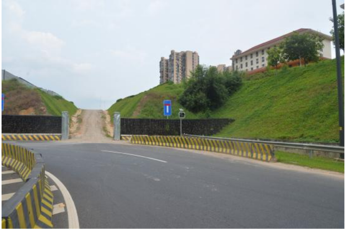
图 31 工程用地地表现状（西—东）
