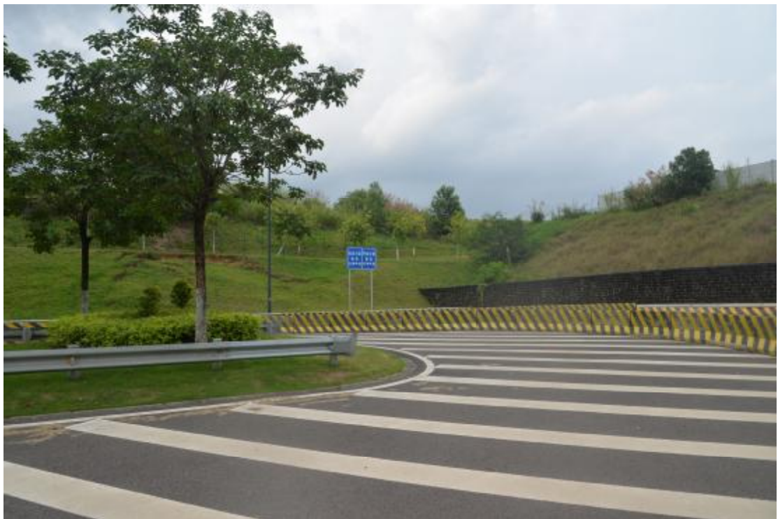
图 30 工程用地地表现状（南—北）
