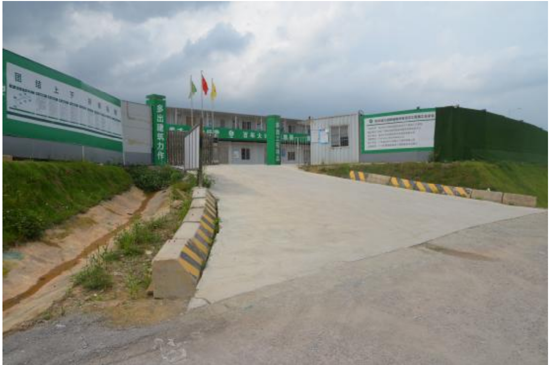
图 37 工程用地地表现状（南—北）
