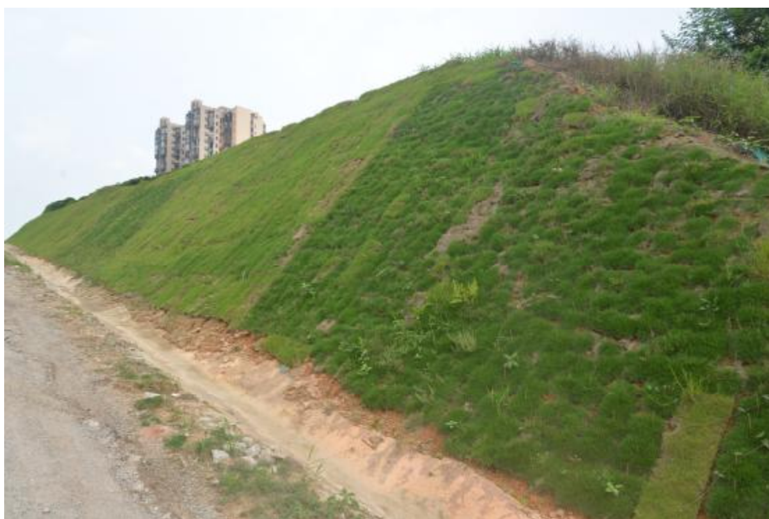
图 34 工程用地地表现状（西—东）
