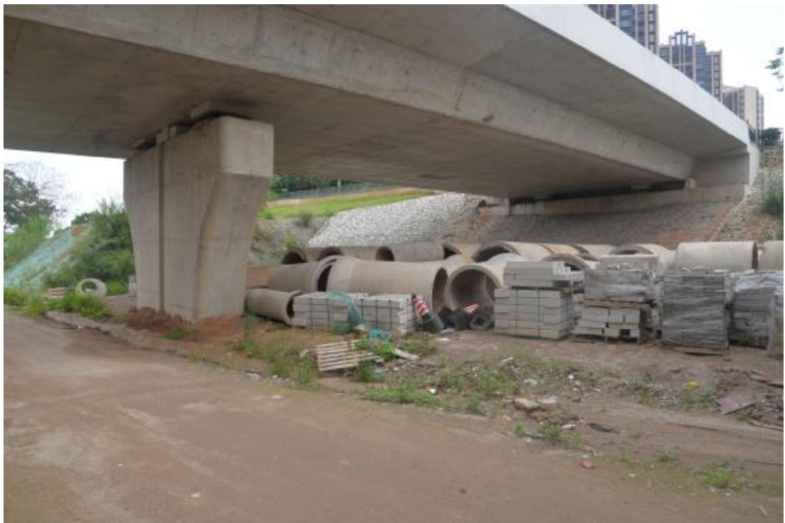
图 46 工程用地地表现状（西—东）
