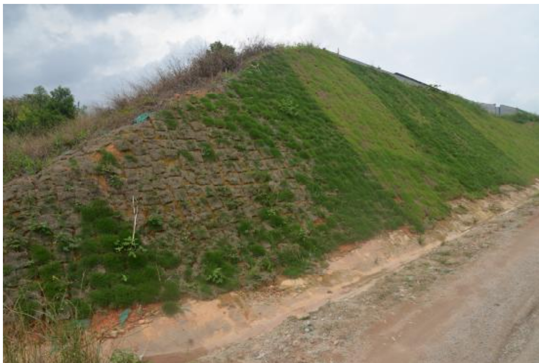
图 33 工程用地地表现状（南—北）
