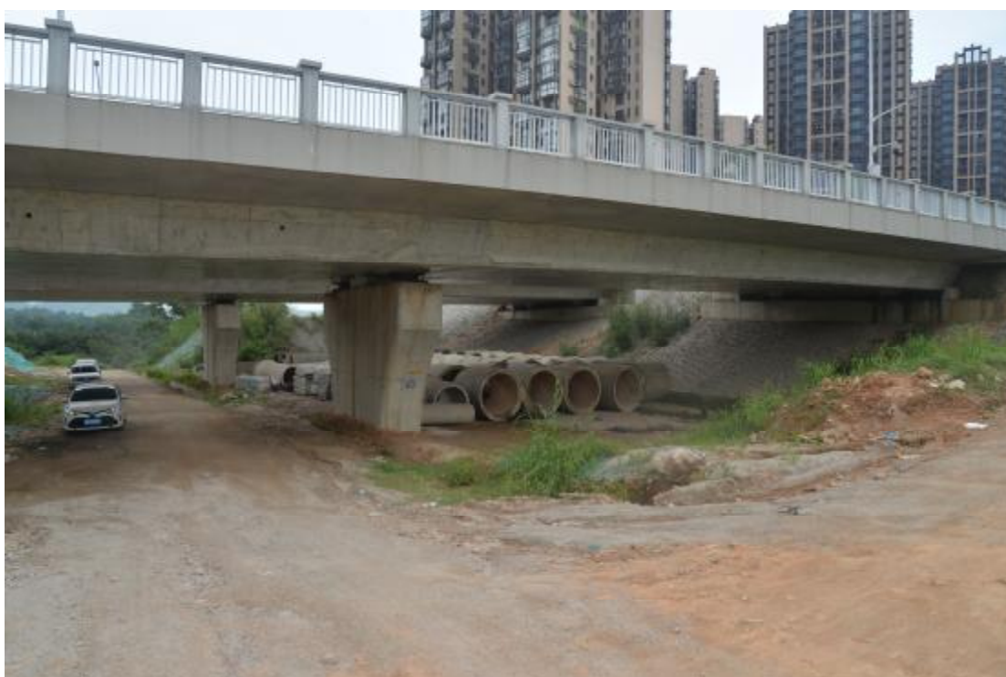
图 42 工程用地地表现状（西—东）
