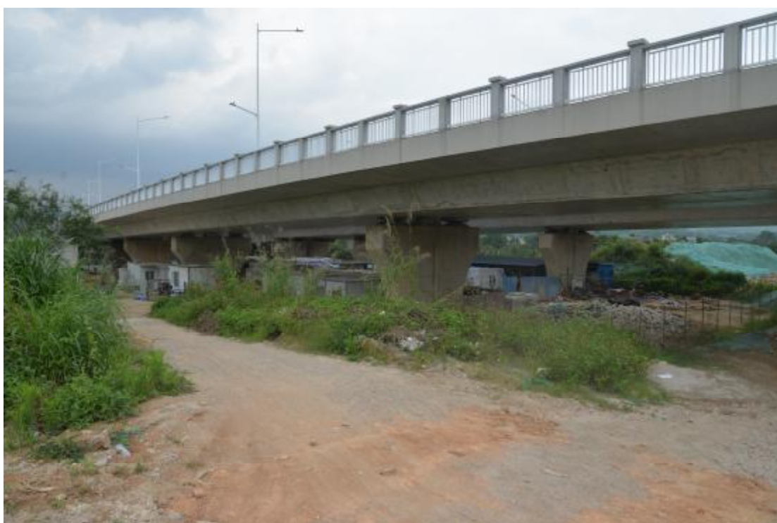
图 40 工程用地地表现状（南—北）
