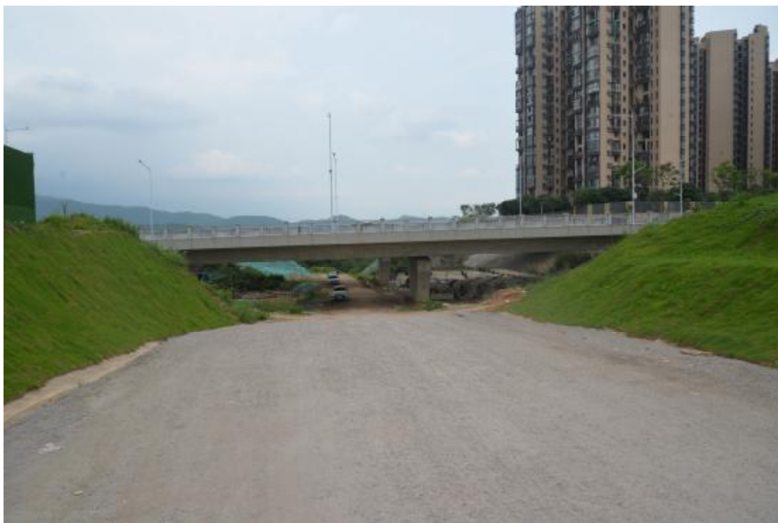
图 39 工程用地地表现状（西—东）
