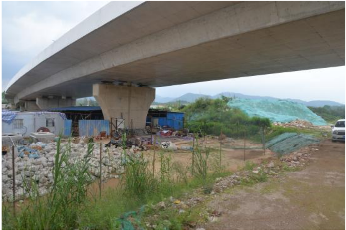
图 45 工程用地地表现状（南—北）
