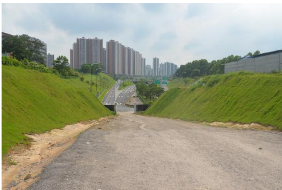
图 50 工程用地地表现状（东—西）
