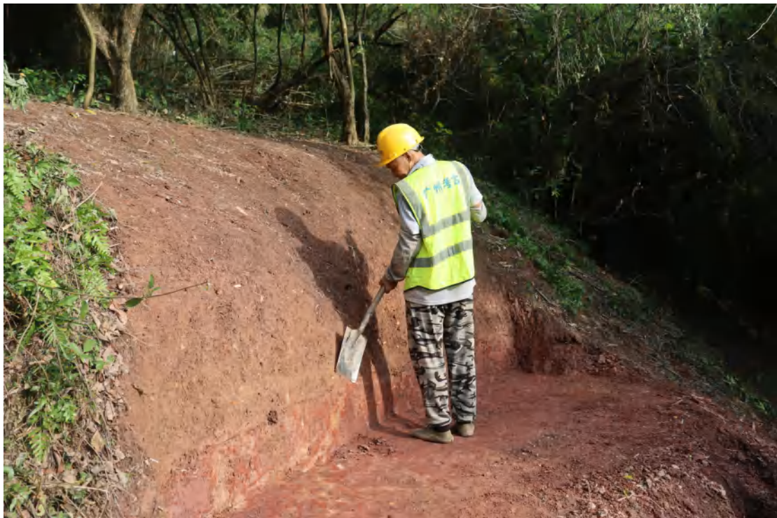
图 70 清理断面（东南-西北）
